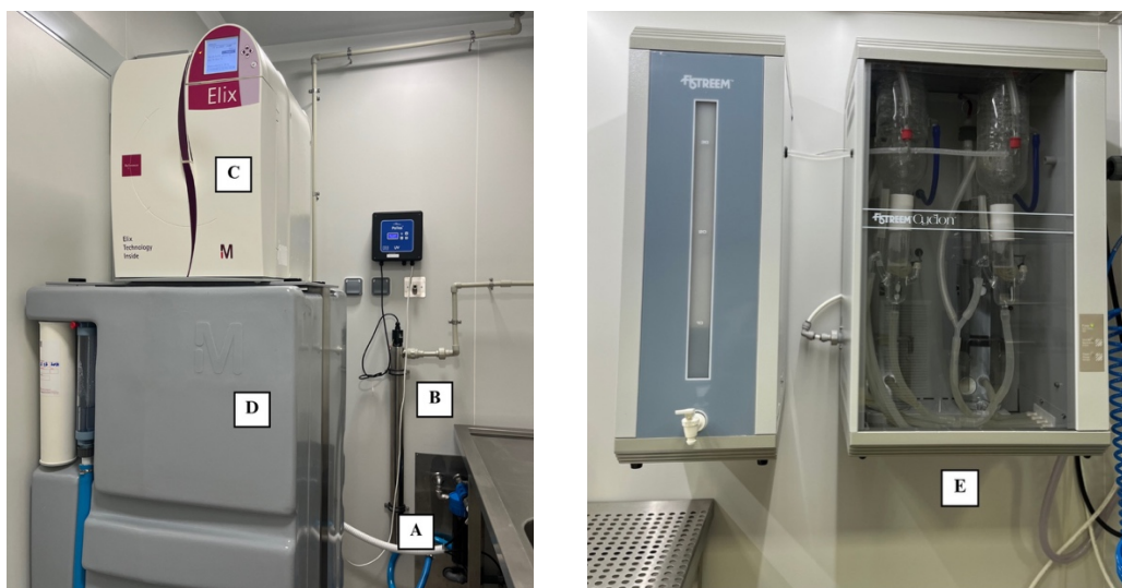
Figura 2. Sistema de Purificação de Água. A- Filtração; B- Lâmpada UV; C- Osmose Inversa; D- Sistema de armazenamento e distribuição; E- Destilação.
