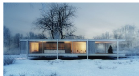
Figura 7 - Farnsworth House - Mies van der Rohe, 1951.
