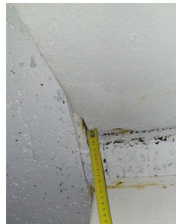
Figura 60 - Isolamento em aglomerado de cortiça
