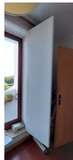
Figura 62 - A proteção solar em portada
