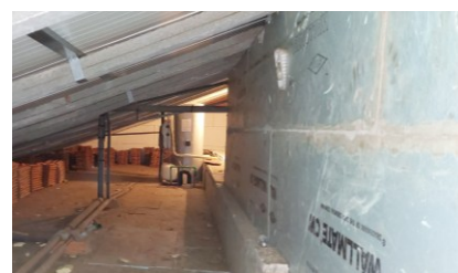
Figura 61 - Desvão de cobertura. Pormenor da cobertura e do isolamento da parede de fronteira com o sótão.
