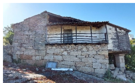
Figura 13 - Habitação tradicional – Sonim - Nordeste Transmontano. A varanda no quadrante Sul
