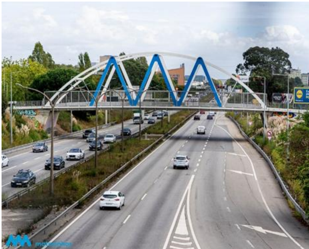
Figura 29 – Viaduto sobre a A28, ligando a Barranha e a Cruz de Pau (Matosinhos) | Autor: Aluno
