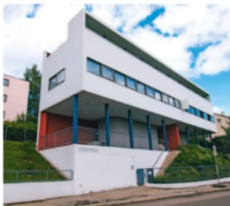
Habitação em Estugarda, de 1927, projetada pelos arquitetos Le Corbusier e Pierre Jeanneret.
