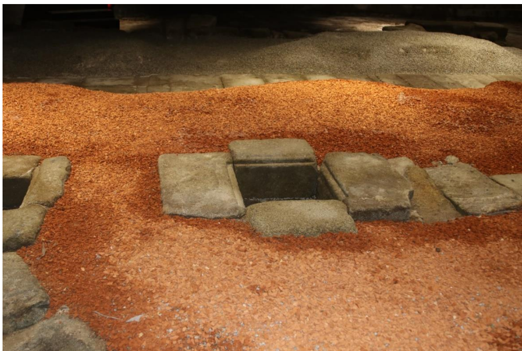
Anexo 1 - Figura 65- Poços de inspeção e derivação das águas das condutas 1 e 2, (Fotografia de autor)
