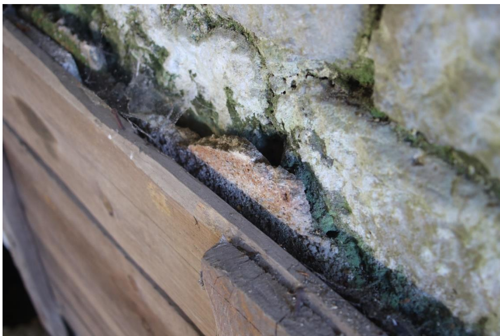
Anexo 1 - Figura 25 - Pormenor do revestimento em opus signinum da cisterna das termas de Tongobriga (Fotografia de autor)
