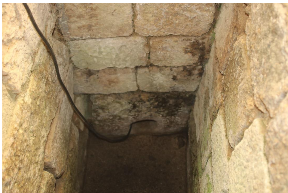
Anexo 1 - Figura 32 - Pormenor da ligação da natatio com o esgoto de Tongobriga (Fotografia de autor)
