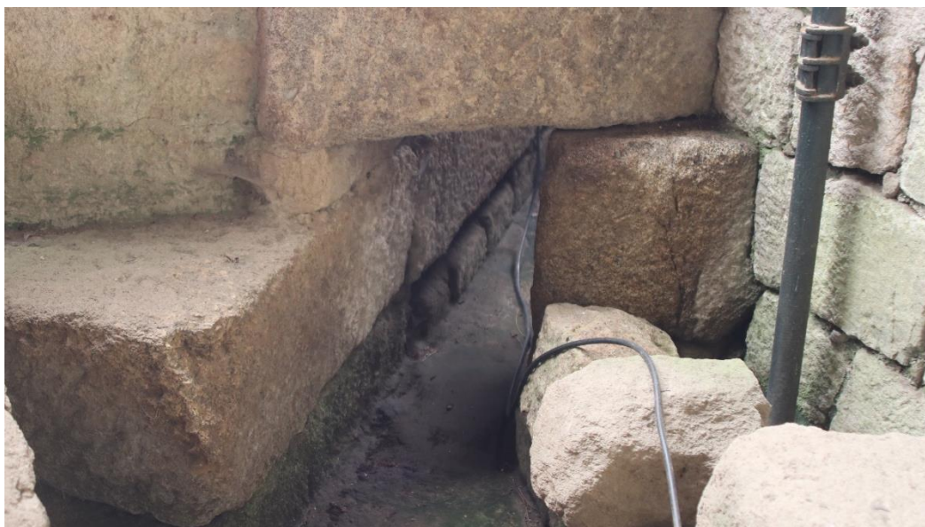
Anexo 1 - Figura 28 - Troço do "esgoto", em direção ao frigidarium das termas romanas de Tongobriga , em opus quadratum (Fotografia de autor)
