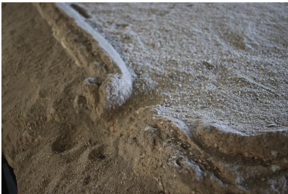
Anexo 1 - Figura 34 - Pormenor dos fundos em opus signinum das piscinas de Tongobriga , para escoamento das águas (Fotografia de autor)
