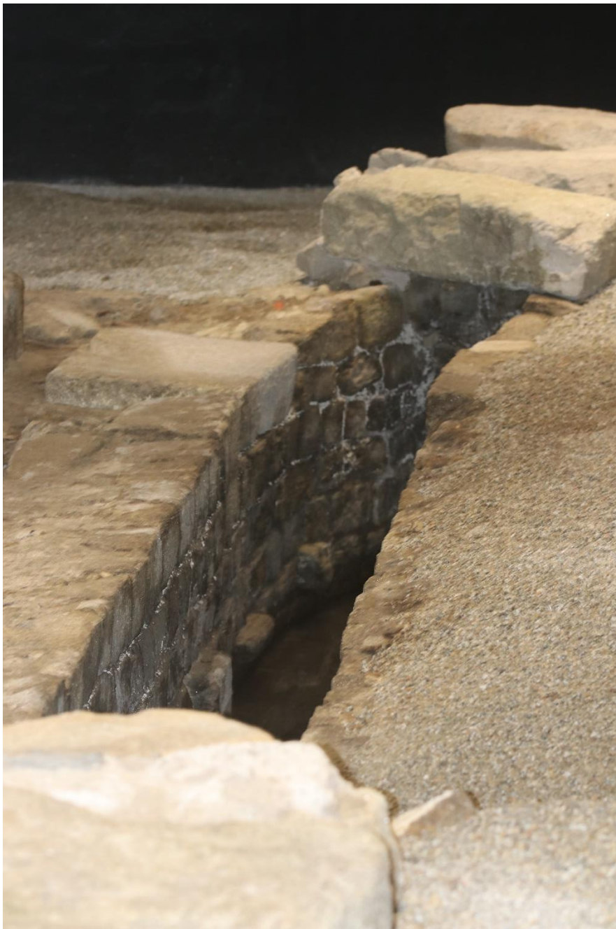
Anexo 1 - Figura 68 - Troço da Cloaca 1 das termas romanas de Chaves, (Fotografia de autor)
