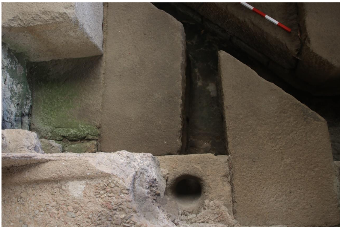
Anexo 1 - Figura 35 - Sifão de pedra para escoamento das águas da piscina do frigidaria de Tongobriga (vista superior, e lateral) (Fotografia de autor)
