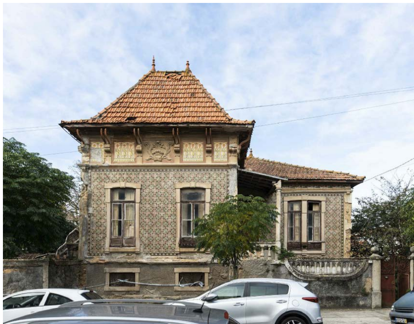
Figura 15 Casa dos Girassóis em Espinho - Aveiro. Fotografia de Mariana Pinto Cardoso presente na dissertação As Casas de Brasileiro em Espinho: Reabilitação da Casa dos Girassóis , 2020. Data da fotografia não especificada.
