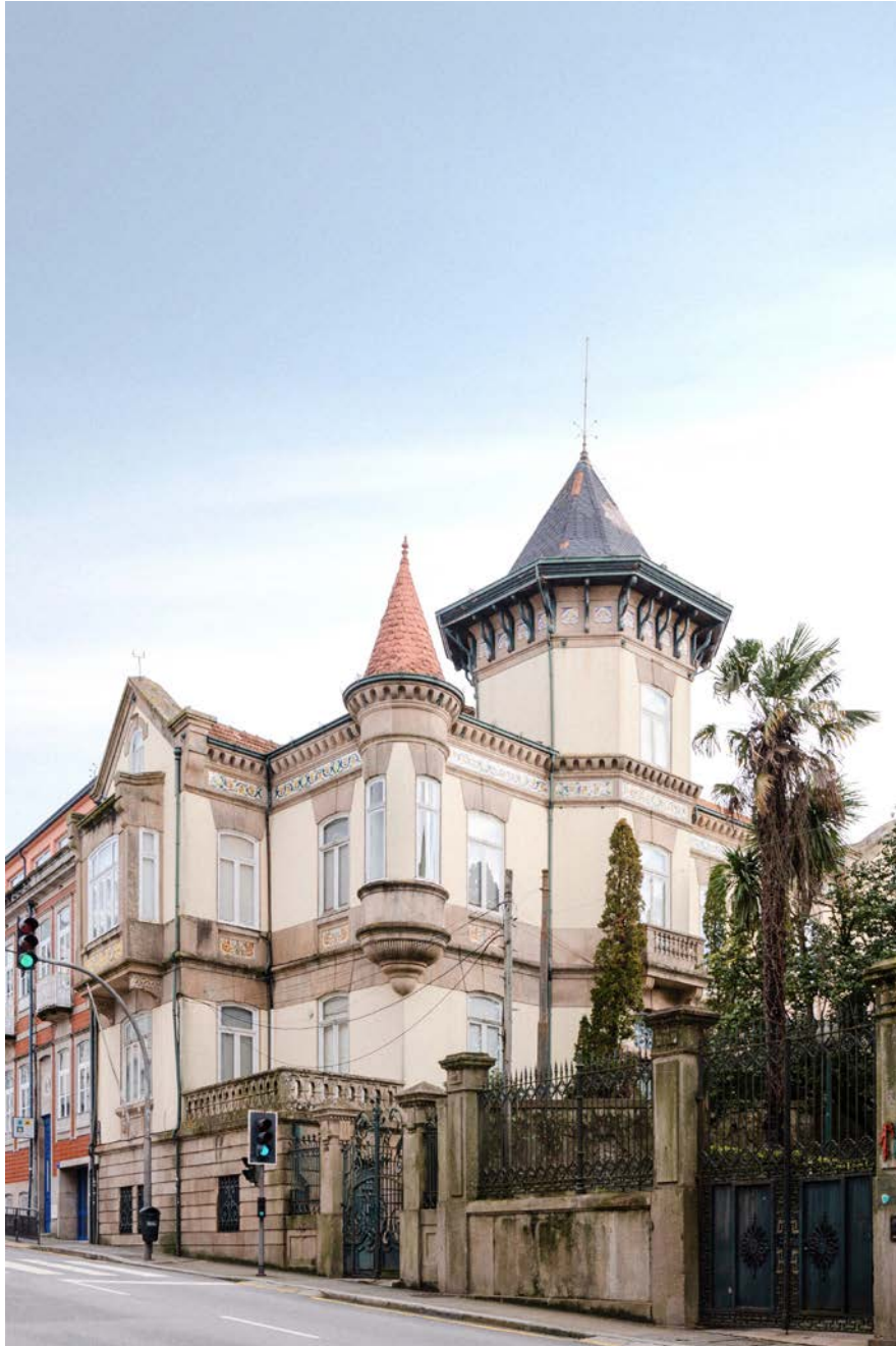
Figura 28A Fotografia do estado atual da Casa de António Pereira da Silva, 2025. Fotografia do autor.
