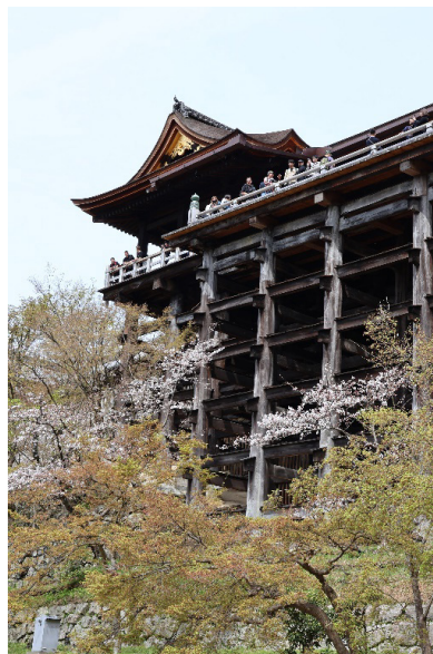
Figura 2.2 - Pavilhão principal do santuário de Kiyomizu-dera construído sobre uma estrutura de 13m de altura feita de madeira de zelkova.
