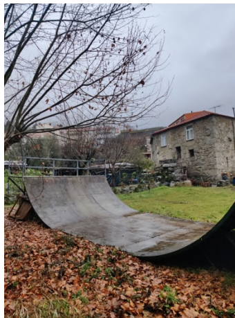
Figura 36 - Fotografia de infraestruturas degradadas no local. Fonte: Inês Ribeiro, OH!LAND Studio
