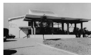
[47] Fachada sul (S) da adega, durante a fase inicial de funcionamento, onde se distingue o volume de serviços, a área de produção e o tegão.
