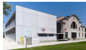
[65] Vista exterior do edifício da antiga Adega Cooperativa de Allègre-les-Fumades, destacando, do lado esquerdo, o volume adicionado e, do lado direito, a fachada norte (N) original.
