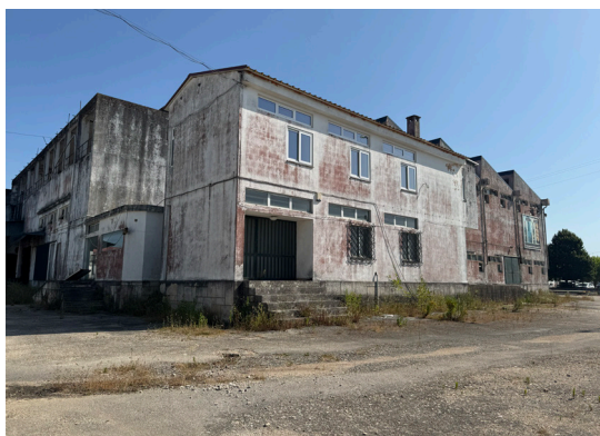
[38] Fachadas norte (N) e oeste (O) da adega, onde se destaca, em primeiro plano, o volume de serviços.
