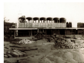
[27] Fachada sul (S) durante a fase de construção, onde é visível o tégão original, mais tarde substituído.
