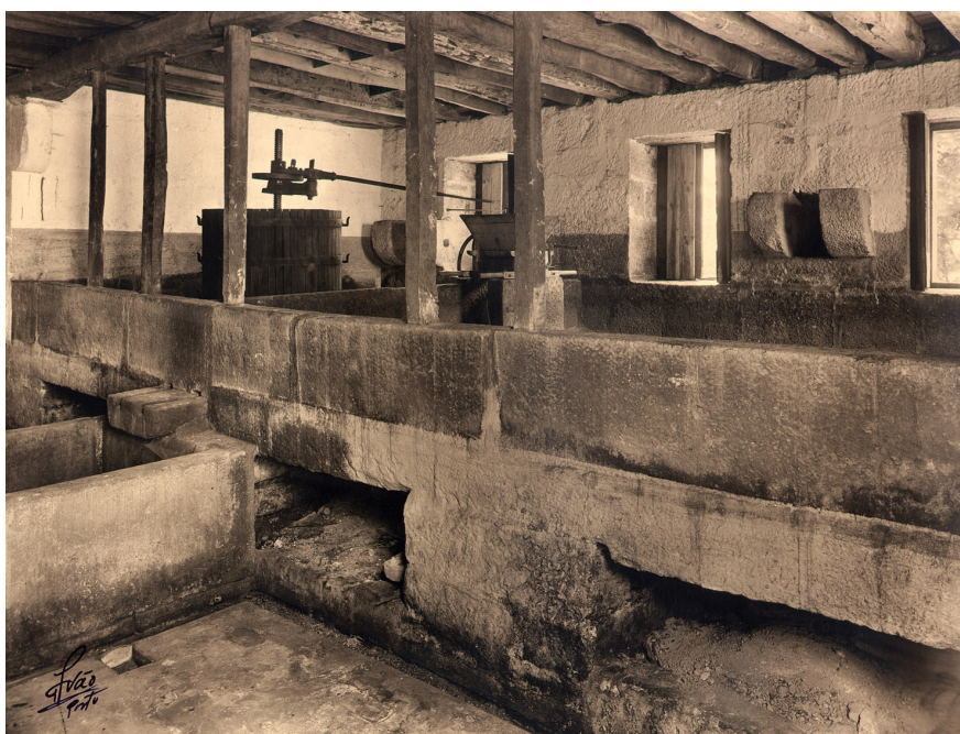
[58] Adega coberta por uma estrutura totalmente em madeira, com tanques em pedra e, ao fundo, uma prensa, também de madeira.
