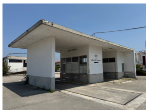
[25] Básculas localizadas junto à entrada da adega, cada uma com área destinada ao controlo da pesagem das cargas e à recolha de amostras das vindimas.
