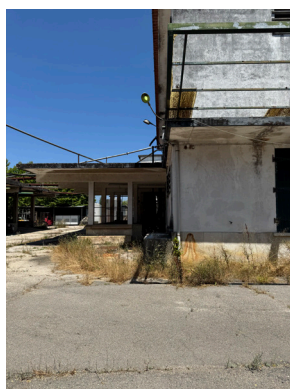
[17] Fachada oeste (O) resultante da adaptação ao funcionamento como adega, com o tegão e a área de produção.
