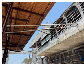
[26] Conduitas para transferência do mosto do tégão para as ânforas de fermentação.
