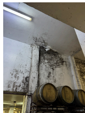
[55] Área de produção da Adega Cooperativa de Cantanhede, construída pela JNV, onde é visível a degradação provocada pela humidade.
