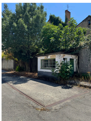
[16] Pequena construção junto à báscula, localizada na entrada da adega, destinada ao controlo da pesagem das cargas e à recolha de amostras das vindimas.
