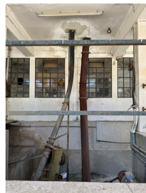
[56] Envidraçados partidos na área de produção da Adega Cooperativa de Mogofores, com pintura degradada, visível na parte superior, e, na parte inferior, o tegão, utilizado no início do processo de vinificação.
