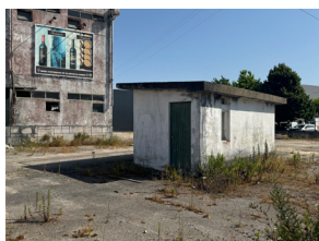
[37] Báscula localizada junto à entrada norte (N) da adega, com espaço dedicado ao controlo das cargas e à recolha de amostras das vindimas.
