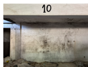
[51] Parede do depósito subterrâneo, com marcas deixadas pelo armazenamento prolongado de garrafas de vinho.
