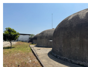
[31] Depósitos airform em betão, localizados no exterior da adega e utilizados para armazenamento do vinho.
