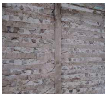
Fig. 113. Tabique, um sistema de construção com grelha de madeira e terra misturada com palha e fibras.
