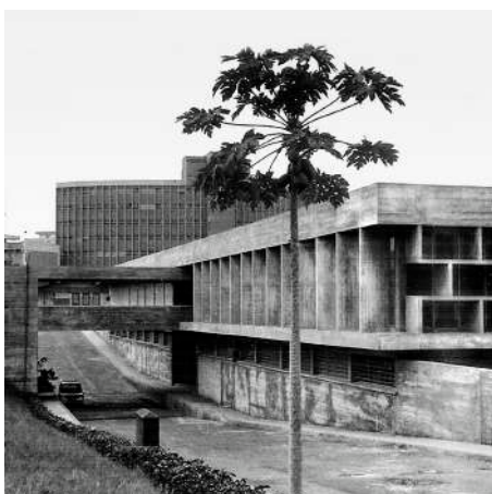
Fig. 39. Rádio Nacional de Angola, na Avenida Comandante Gika, em Alvalade, em 1967. O edifício é envolvido por uma grelha de betão que cobre a fachada envidraçada. Consoante a radiação solar, recorre a lâminas verticais orientadas a 45° sobre a base ou então a uma grelha retangular diferenciada.
