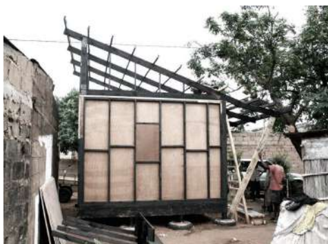
Fig. 106. FASE 1: Construção de habitação pré-fabricada com madeira local e zinco.
