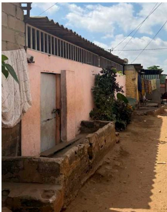
Fig. 93. Elevação da cota da entrada e muro à volta.
