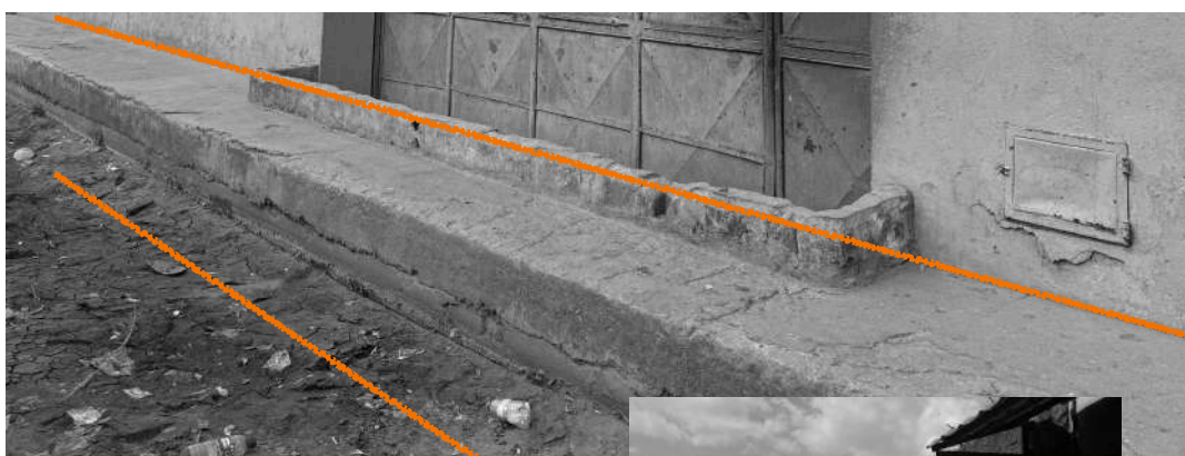
Fig. 120. Alargamento de passeios já existentes e criação de faixas pedonais, mais elevadas em relação à cota da rua, nas imediações das casas.
