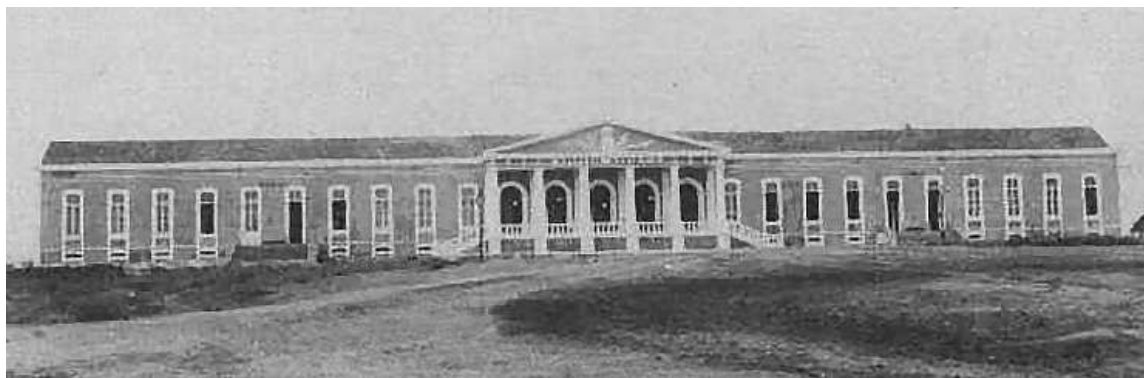
Fig. 37. Hospital D. Maria Pia em 1949. O caráter sustentável deste edifício revela-se pela utilização de pátios, galerias e ventilação cruzada que favorecem a iluminação natural e a refrigeração passiva dos espaços.
