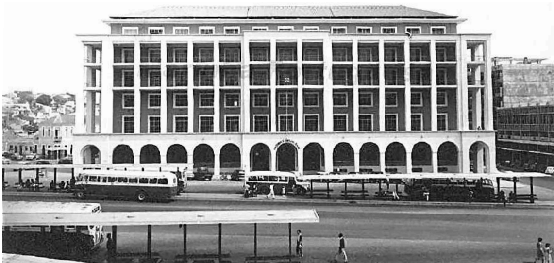
Fig. 38. Ministério das Finanças, na Mutamba, em 1963. O seu conceito sustentável manifesta-se sobretudo através da galeria exterior em arcadas que protege o edifício da radiação solar direta.
