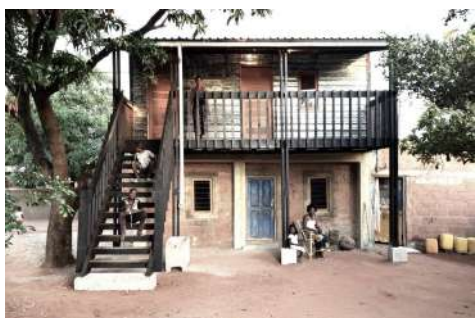
Fig. 108. FASE 3: Construção de habitação pré-fabricada com madeira local e zinco.
