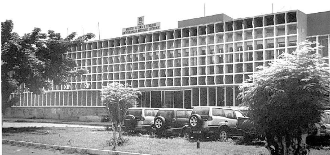
Fig. 40. Centro Nacional de Investigação Científica, na Avenida Ho Chi Min, de 1969. A composição geral do edifício apresenta elementos pré-fabricados de controlo solar verticais ao longo de toda a fachada principal. De forma a hierarquizar a entrada principal, recorreu a elementos quadrados que formam uma grelha e compõem uma fachada secundária.
