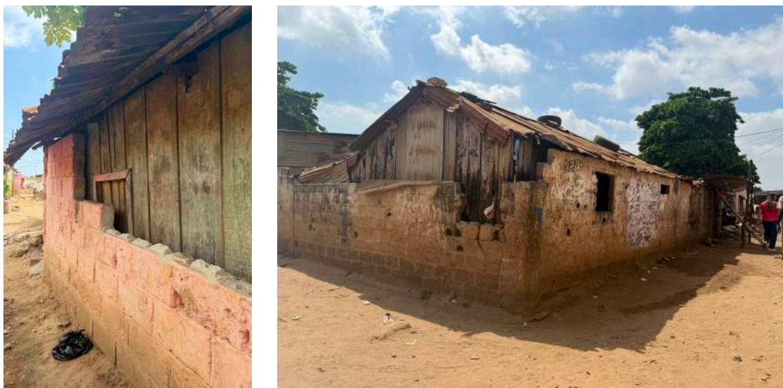
Fig. 85. Casas de madeira, do período colonial, revestidas posteriormente com blocos de pedra.
