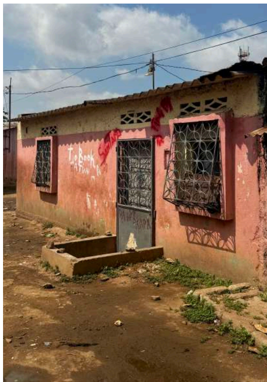
Fig. 92. Proteção da entrada de casa com muro.
