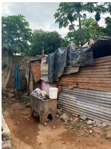
Fig. 81. No próprio quintal são improvisadas casas de banho e espaços de estar, maioritariamente com chapas metálicas, lonas e paus de madeira. Os moradores recorrem também à pedra para delimitar espaços, apoiar as estruturas ou até mesmo impedir que as águas da chuva possam descer para o interior.
