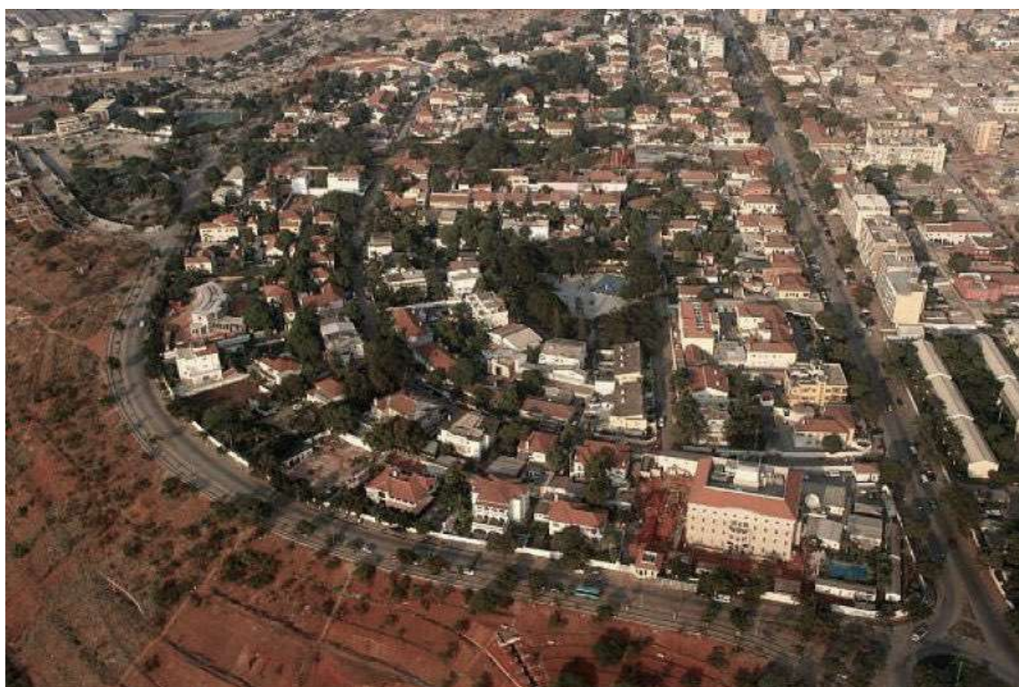
Fig. 64. Vista aérea do bairro do Miramar.
