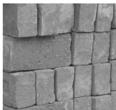
Fig. 102. Blocos feitos com terra, comprimidos com tábuas de madeira e secos pelo sol, improvisando estruturas.
