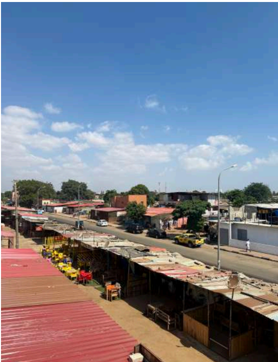
Fig. 70. Vista para a Rua 12 de julho.
