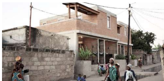
Fig. 109. FASE 4: Construção de duas casas geminadas de dois andares, com a possibilidade de adicionar um terceiro andar.
