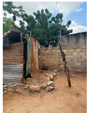
Fig. 81. No próprio quintal são improvisadas casas de banho e espaços de estar, maioritariamente com chapas metálicas, lonas e paus de madeira. Os moradores recorrem também à pedra para delimitar espaços, apoiar as estruturas ou até mesmo impedir que as águas da chuva possam descer para o interior.
