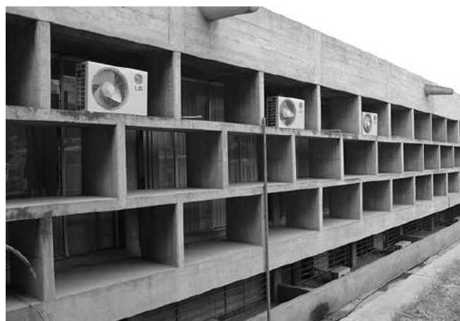
Fig. 39. Rádio Nacional de Angola, na Avenida Comandante Gika, em Alvalade, em 1967. O edifício é envolvido por uma grelha de betão que cobre a fachada envidraçada. Consoante a radiação solar, recorre a lâminas verticais orientadas a 45° sobre a base ou então a uma grelha retangular diferenciada.
