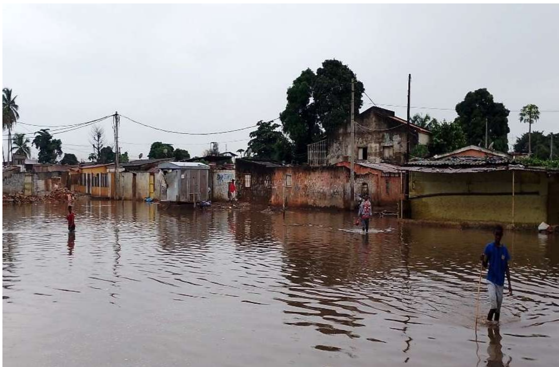
Fig. 89. Rua após situação de chuva intensa.
