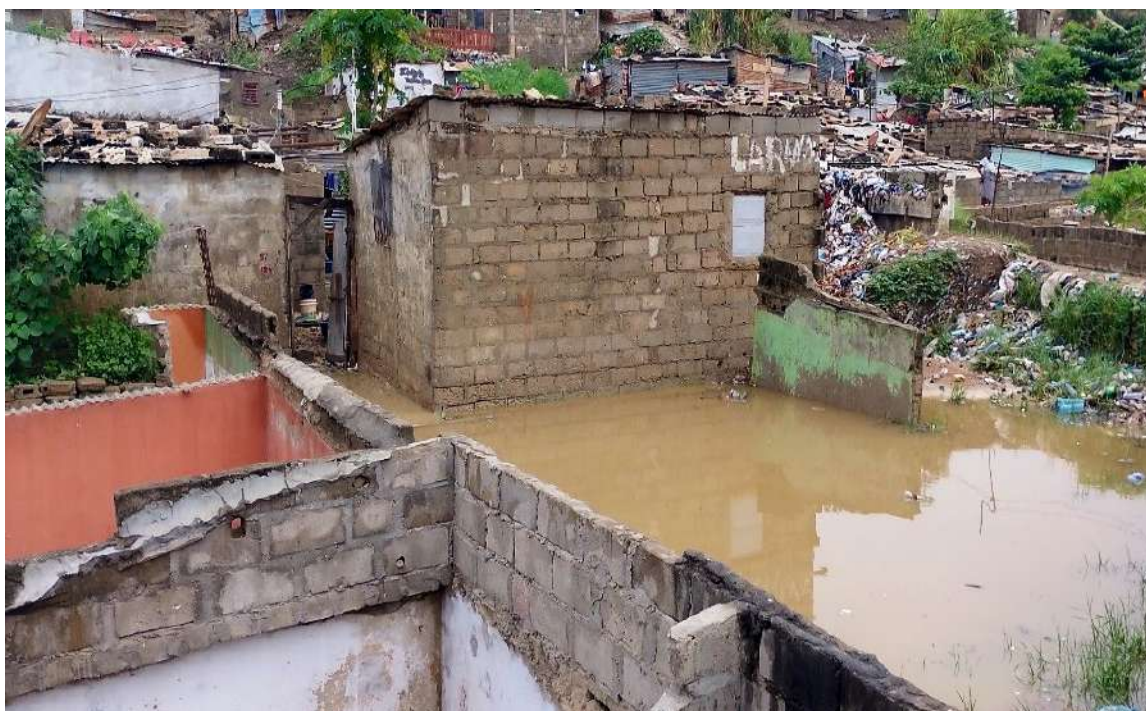
Fig. 90. Encosta no setor da Madeira, com amontoado de lixo arrastado pela chuva.
