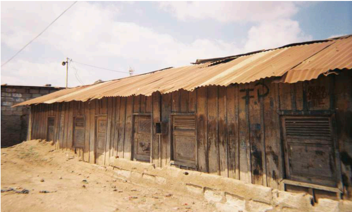
Fig. 73. Casa de madeira parcialmente enterrada no solo.
