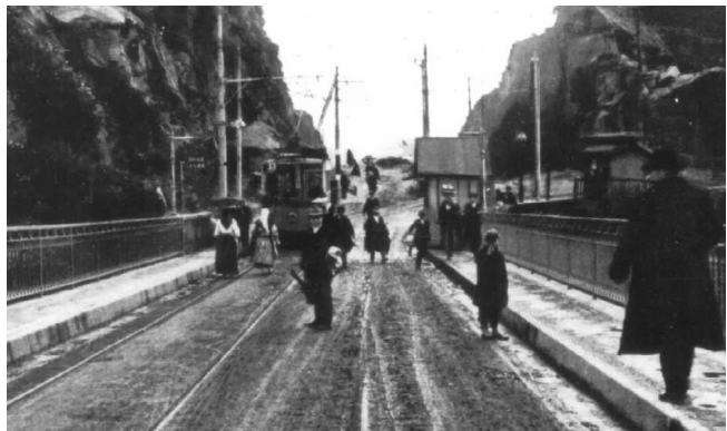
Fig. 57 - Vista do tabuleiro superior da Ponte D. Luís I
