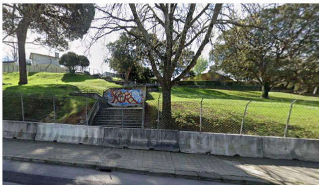
Fig. 79 - Gradeamento de jardim e acesso na rua Diogo Botelho.
