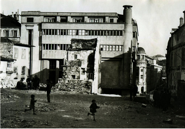
Fig. 67 - Demolições no quarteirão para dar lugar à Praça Filipa de Lencastre, dando um novo destaque ao edifício da Garagem do Porto de Rogério de Azevedo.
