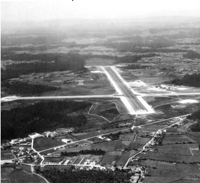
Fig. 70 - Vista aérea do aeroporto de Sá Carneiro.
