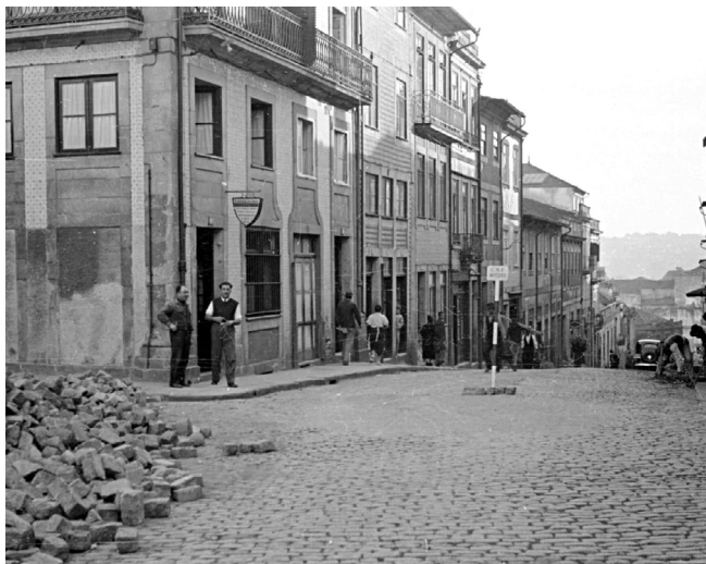
Fig. 105 - Obras de pavimentação do largo de Mompilher e da rua da Picaria, em 1939.
