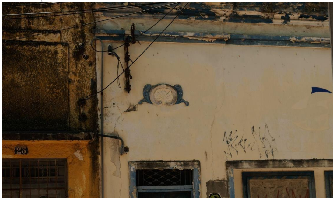
Figura 76 - Fachadas e ornamentos, 28 de fevereiro de 2023, Rua João Fernandes Vieira. Fotografia de Ana Flávia Mendonça.
