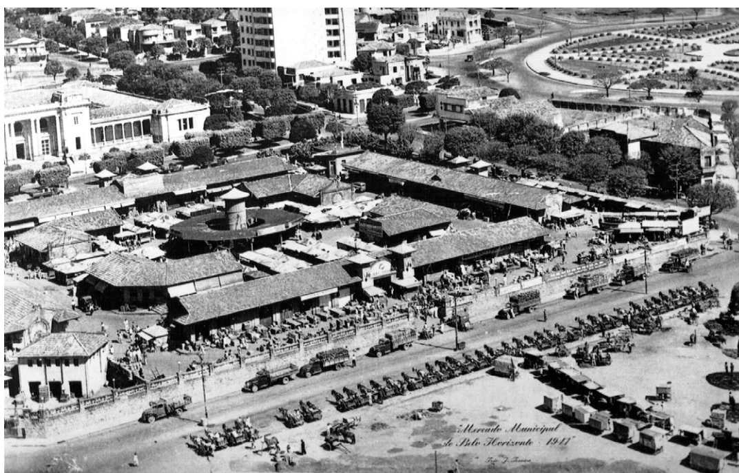
Imagem 27 Fotografia aérea do Mercado Central em suas primeiras décadas de funcionamento.
