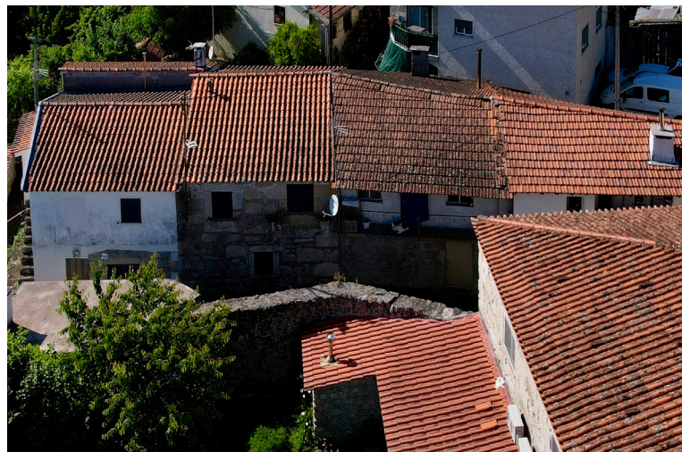
39| Alçado sudeste. Travessa da Lavandeira. Envolvente.
