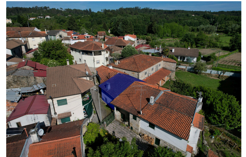
34I Enquadramento do objeto. Rua do Rêgo. Vista noroeste.
