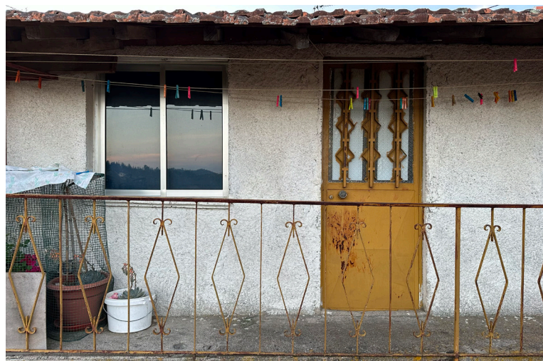
40| Aproximação. Piso superior. A Casa de Couto de Cima.
