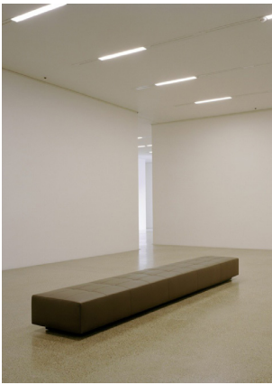
Betonilha Polida nos Pavimentos
