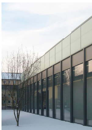
Estruturas em Aço
