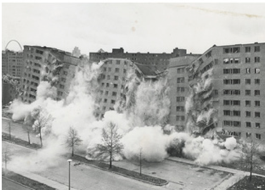
14| Demolição do Pruitt-Igoe Housing Project por Minoru Yamasaki. Fonte: Archdaily
