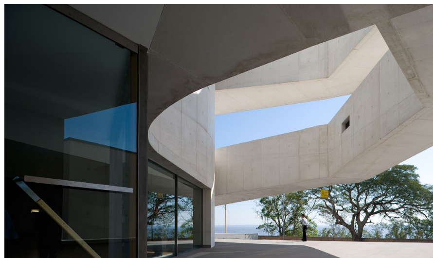
Figura 56. Acceso al Fundación Iberê Camargo y vacío y rampas exteriores. Fuente: Fernando Guerra
