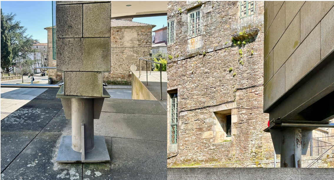
Figura 26. Vista detalle del muro perimetral de acceso al CGAC. Fuente: Autor
