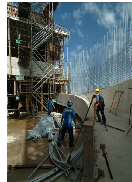
Figura 55. Construcción de la Fundación Iberê Camargo vista desde el atrio y las rampas interiores. Fuente: Archivo FIC
