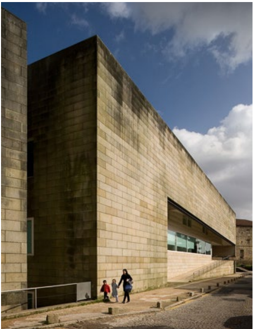
Figura 45. Vista noroeste del muro y rampa de acceso al edificio. Fuente: Fernando Guerra
