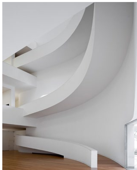
Figura 59. Vista de las rampas y muros desde el atrio de acceso. Fuente: Fernando Guerra
