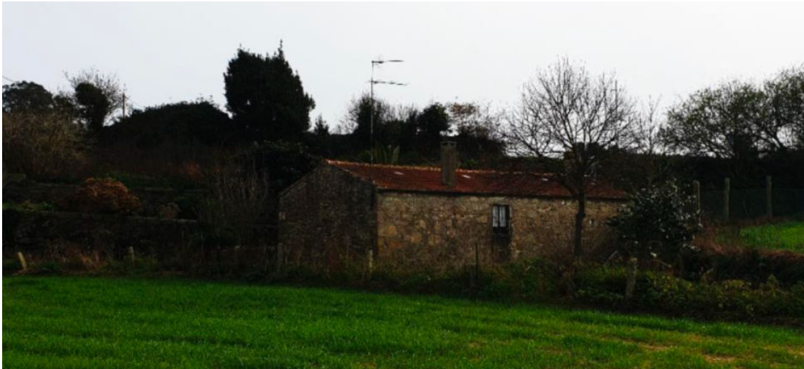
Figura 40 Azenha localizada na freguesia de Matosinhos
