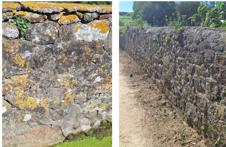
Figura 34- Muros de pedra seca
