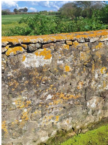
Figura 26- Muros de pedra seca
