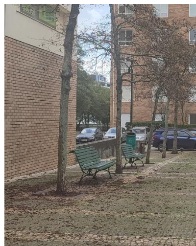
Figura 18 Caleiras inapropriadas para espécie em questão e pavimento degradado sem manutenção Fonte: Fotografia própria em janeiro de 2025
