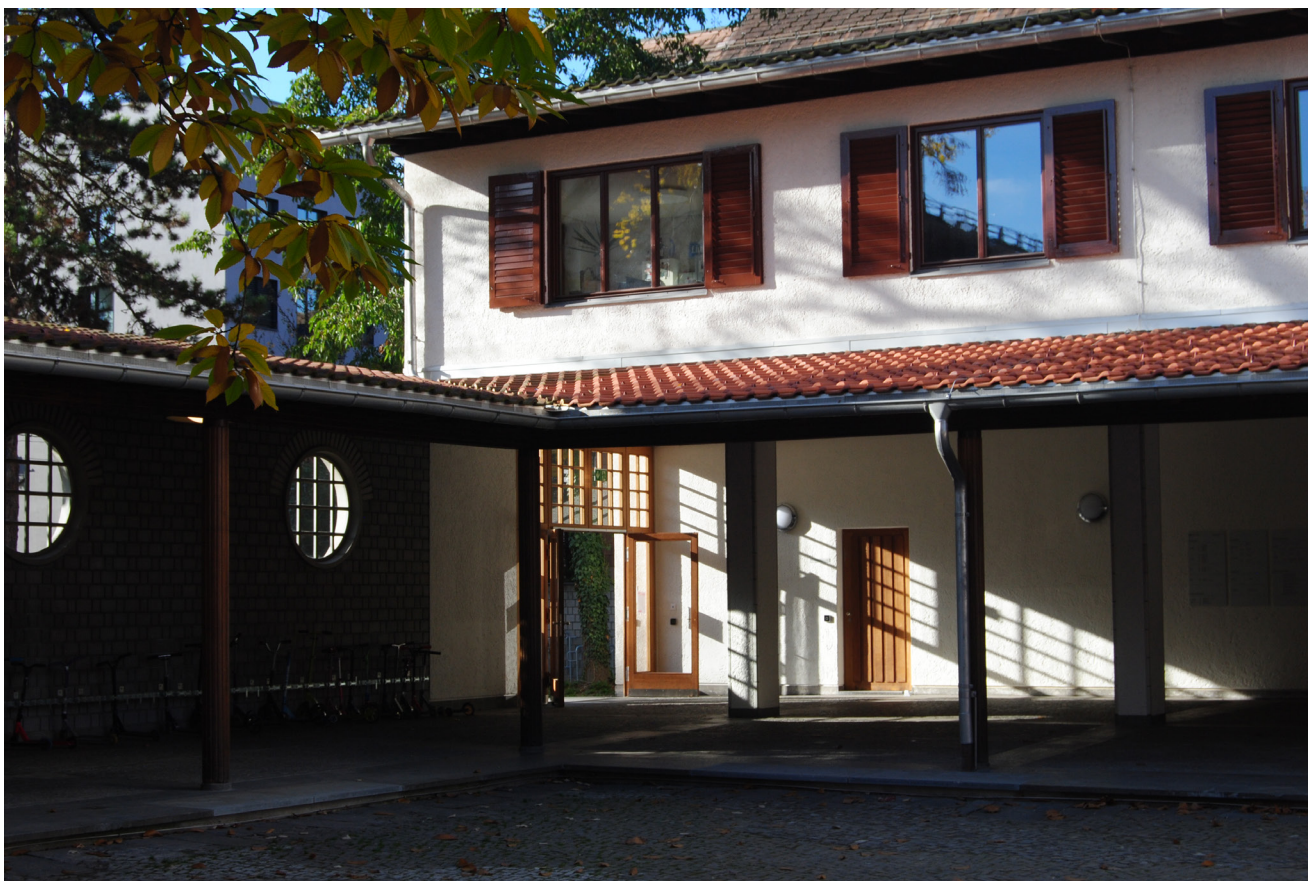
O recreio coberto age como o elemento espacial de transição entre o corpo das aulas e o ginásio. Fotografias próprias, novembro 2024.
