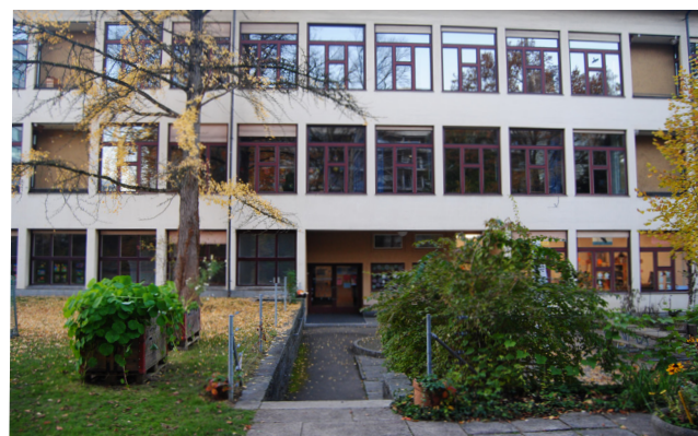
O recreio dos pequenos e a fachada secundária. Fotografia própria, novembro 2024
