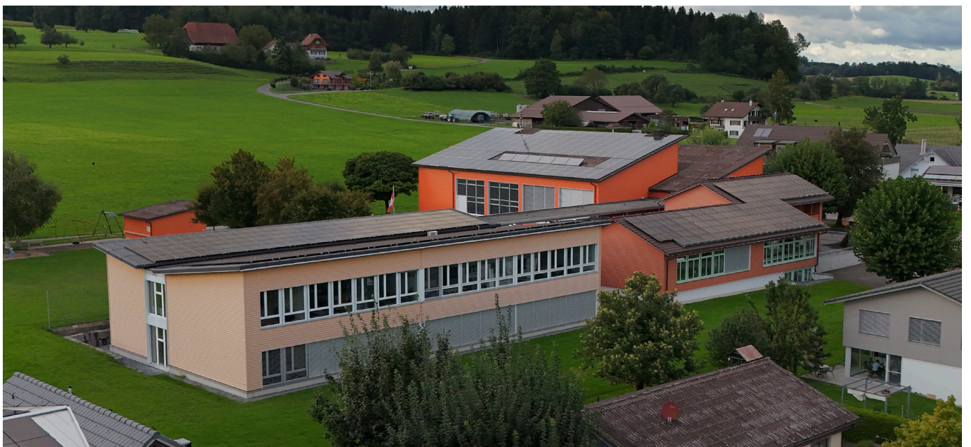
Vista drone da escola atual.
