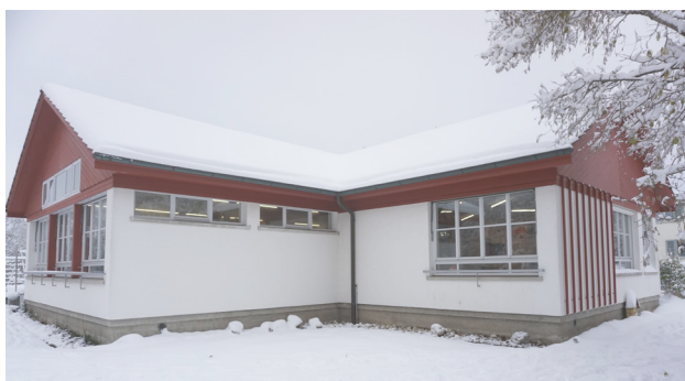
A forma em cruz permite abrigar-se do vento no recreio. Fotografia própria, novembro 2024.
