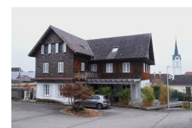
A câmara municipal, primeiro espaço escolar em Abtwil. Fonte: Fotografia própria, dezembro 2024.
