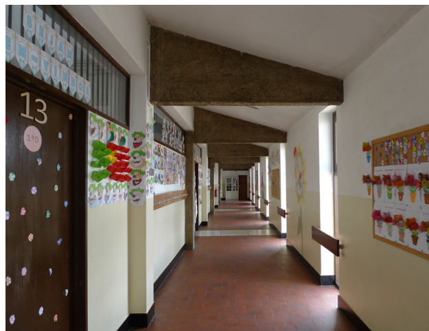
Diferença estrutural entre o corredor de baixo e o de cima
