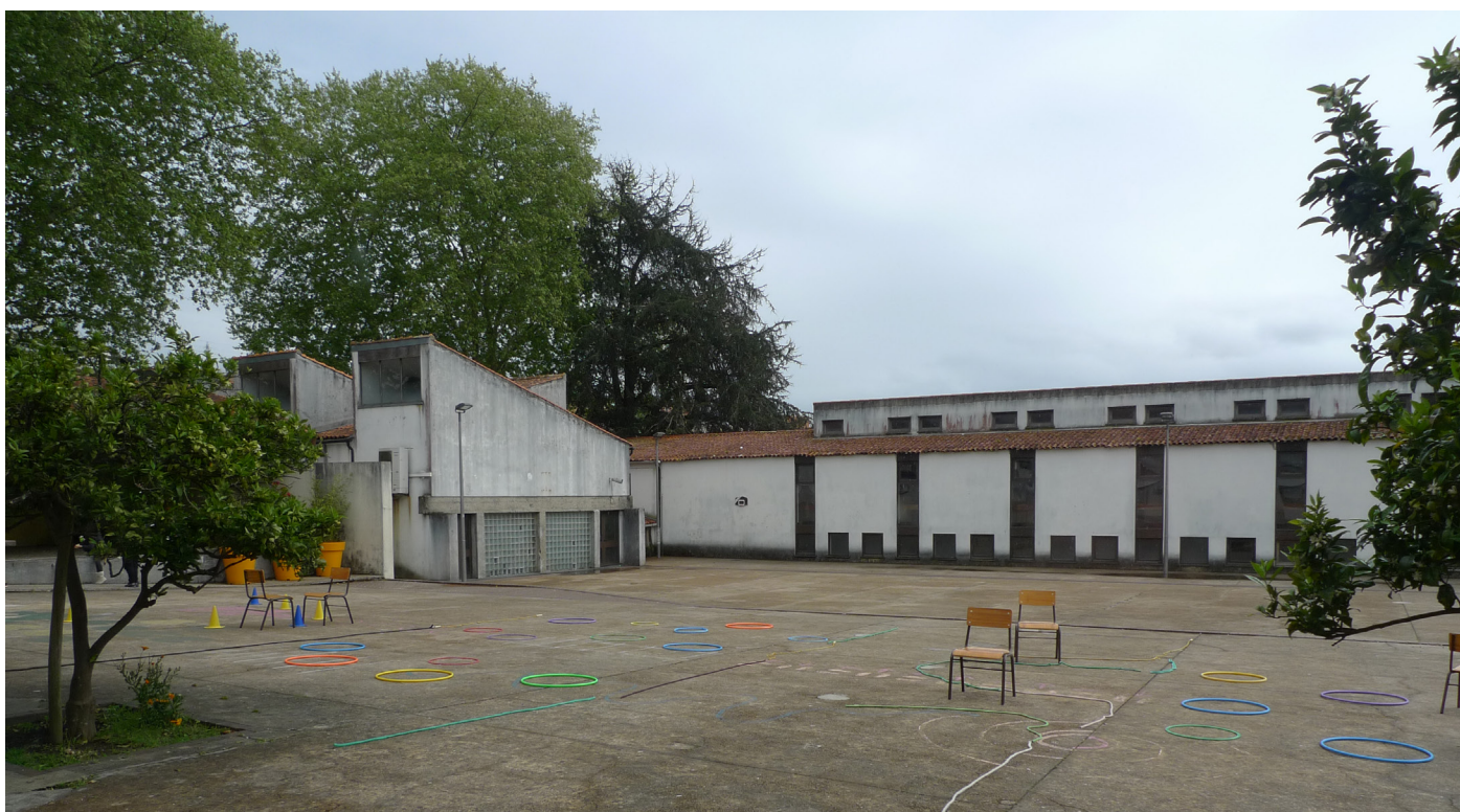
Os 3 elementos da escola: a sala comum, o recreio e o corpo das salas. Fotografia própria, abril 2025.
