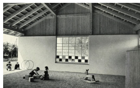
Recreio coberto original. Fonte: Livro 'The New School' , ed. 1950, p76.
