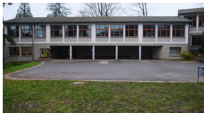
O recreio inferior e o alçado do pavilhão onde tem o jardim de infância. Fotografia própria, novembro 2024.
