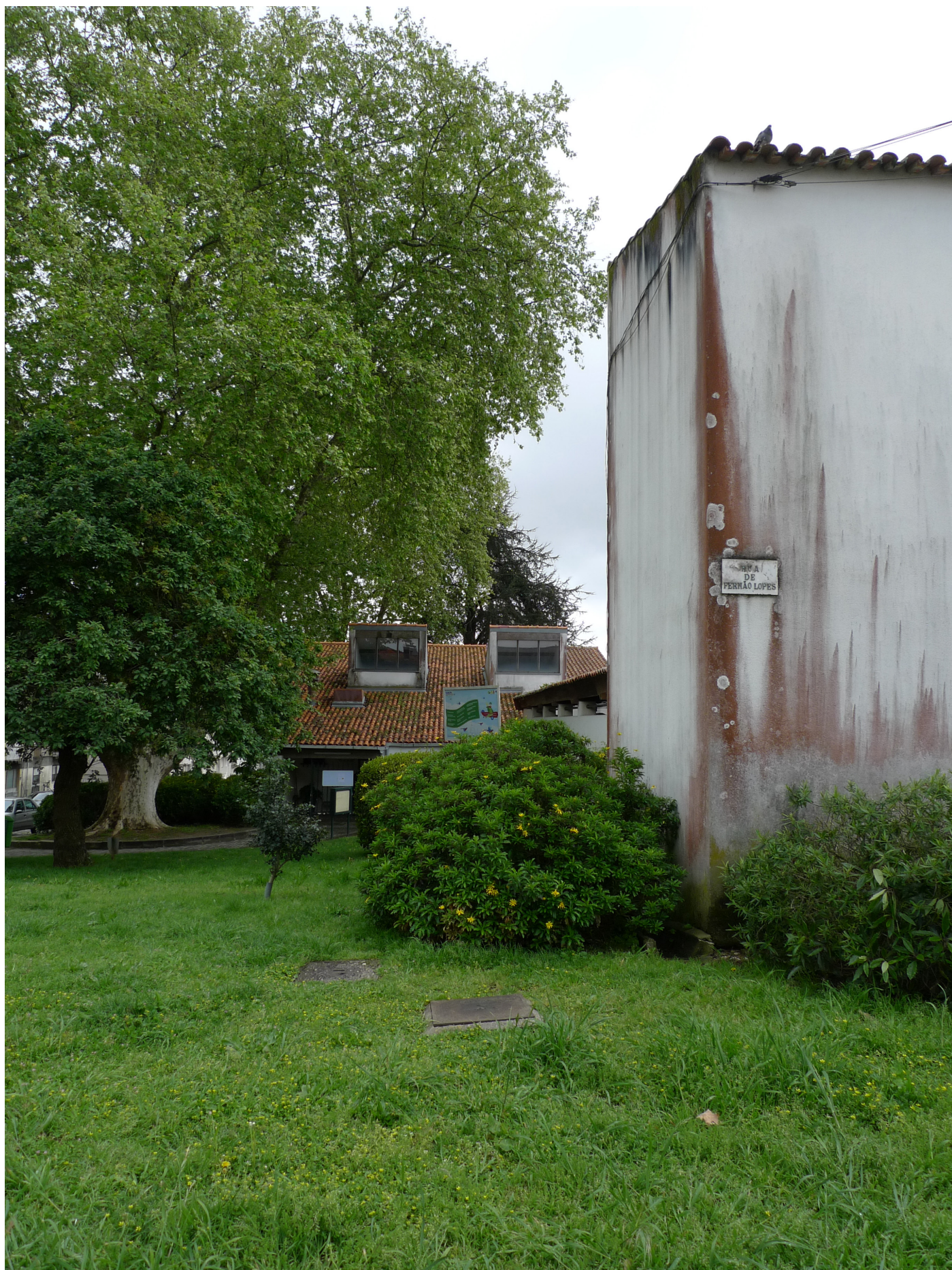
A entrada norte da escola, do outro lado da praça, não fica tão exposta e lembra o caráter doméstico das escolas da New School. Fotografia própria, abril 2025.
