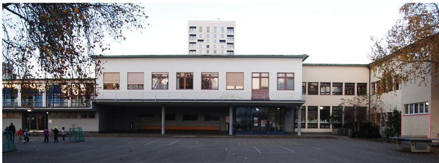
A forte horizontalidad da escola, com cobertura plana, contrasta com os volumes verticais do bairro. Fonte: Fotografia própria, novembro 2024.
