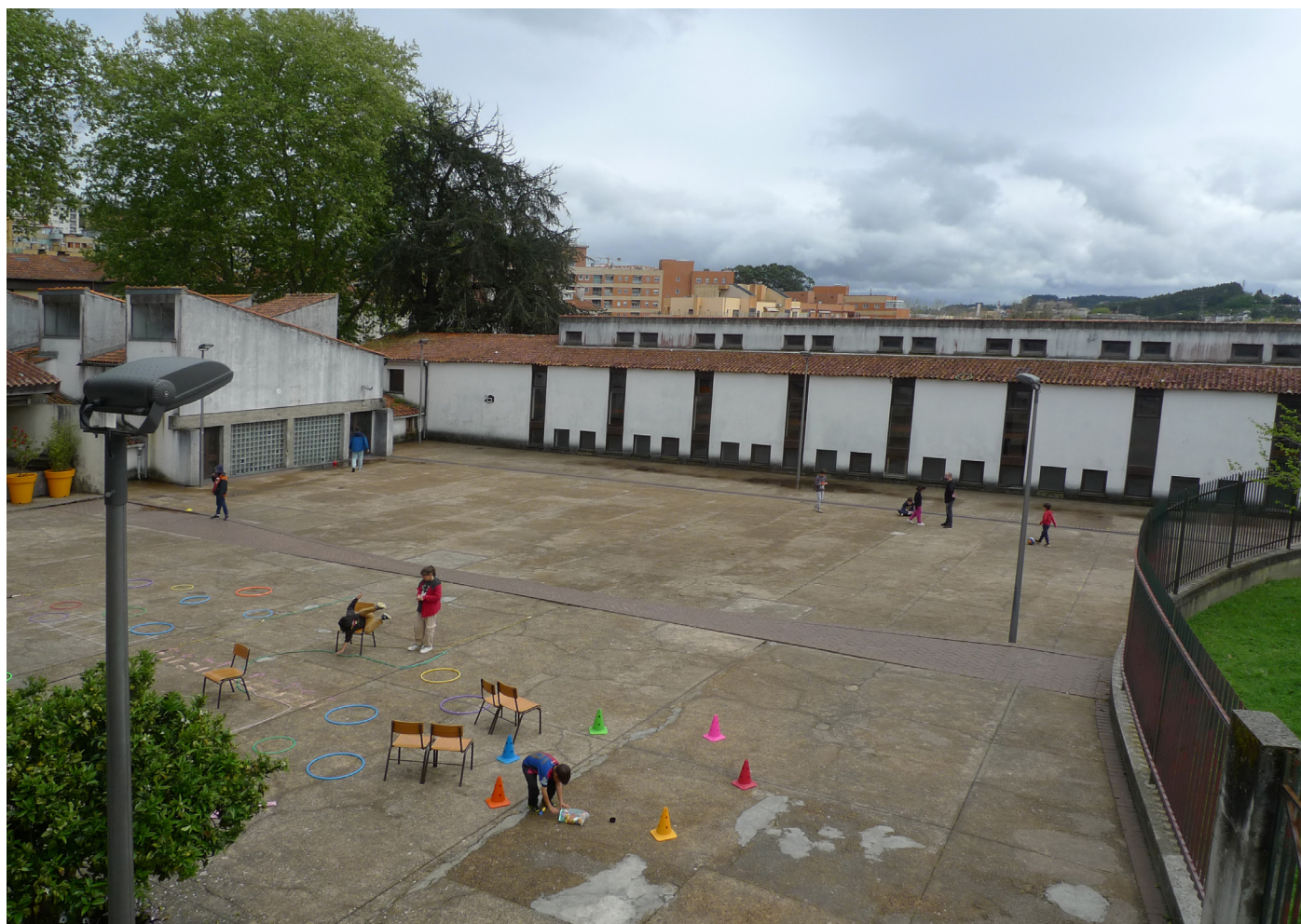
A vista das salas de aula do piso superior sobre o recreio principal. Fotografia própria, abril 2025.
