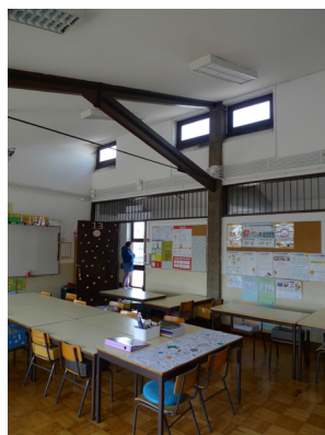
A inclinação da cobertura nas salas do 1º andar traz mais luz no espaço.
