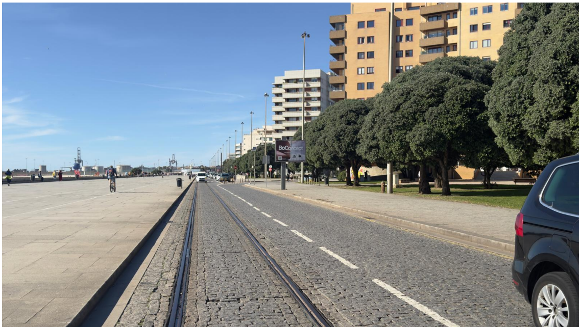
Figura 36 - Avenida General Norton de Matos existente 2025; Fonte: Autor
