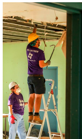
48. Voluntários durante a fase de limpeza e remoção de entulhos após um furacão, All Hands and Hearts , EUA, 2019
