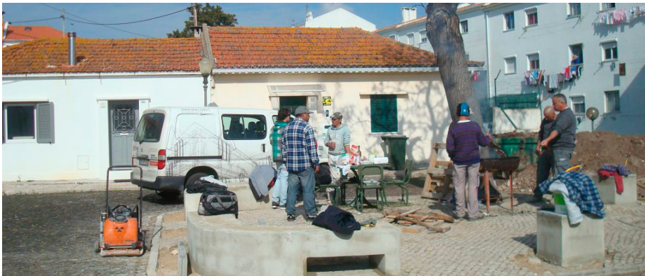
57. Trabalhos de reabilitação do Largo do Cantinho, Bairro 2 de Maio, Lisboa, 2014
