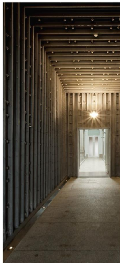
Imagem 30- Casa Forte após obra de reabilitação. © Inc D'ourey. 2009.
