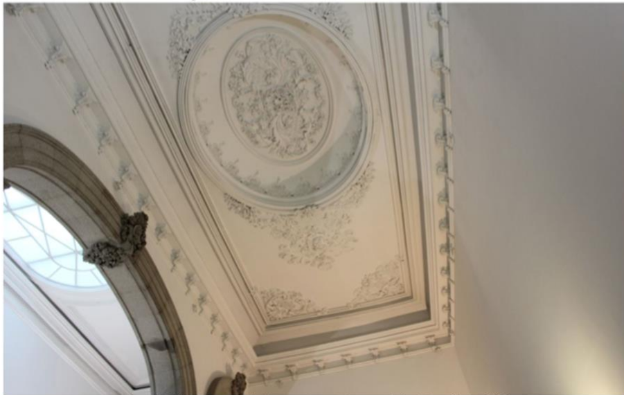
Figura 17- Perspetiva geral do teto em estuque sobre a escadaria. © Ana Gomes. 2025.
