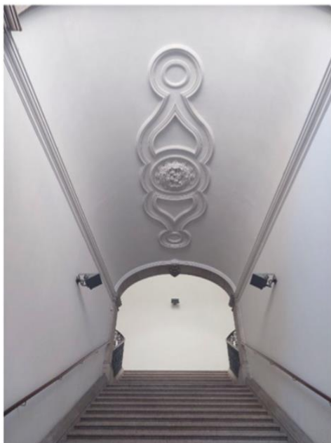
Imagem 12- Arranque da escadaria central com cobertura em forma de abóbada em berço. Destaca-se um elemento decorativo em estuque. © Ana Gomes, 2025.
