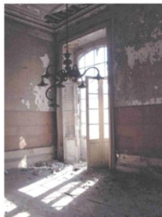
Imagem 41- A Sala central do Piso Nobre antes da reabilitação era a única que não tinha uma laje de betão. Durante a ocupação da Companhia Seguros Douro, esta sala era utilizada como secretariado. Memória descritiva, 2005.
