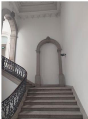
14 Figura 16- Arco cego do alçado nascente, Rua Sousa Viterbo. © Ana Gomes. 2025.
