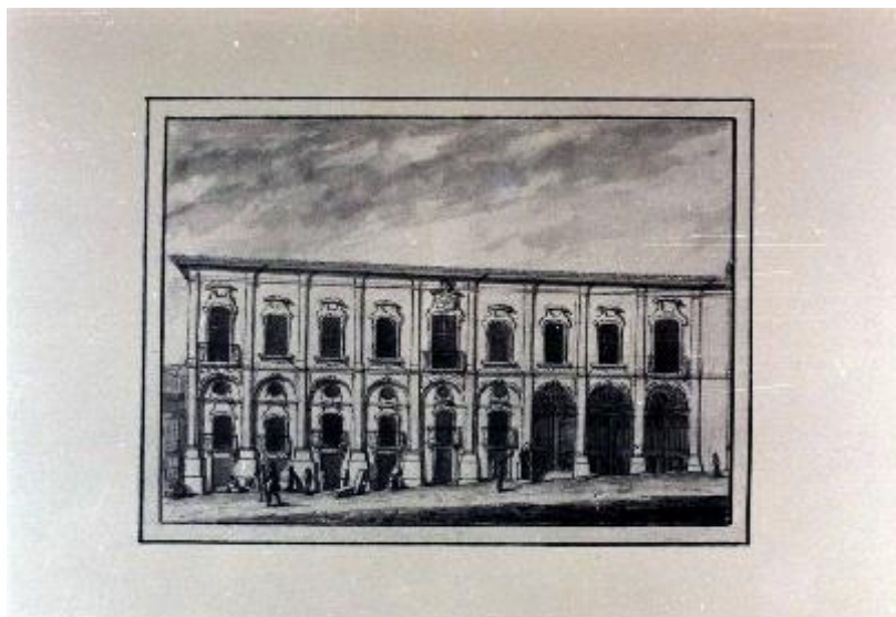
Figura 12-Reprodução de uma gravura de Joaquim Cardoso Vilanova do Convento de São Domingos. Álbum «Edifícios do Porto em 1833». Fonte: Gisaweb (F-C/CMP/8/202)
