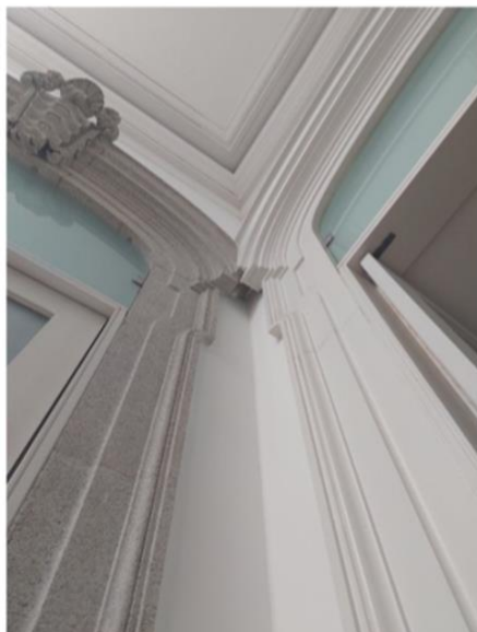
Imagem 27- Diálogo entre a pré-existência dos feixes de granito originais e um feixe de madeira pintada de branco. © Ana Gomes, 2025.
