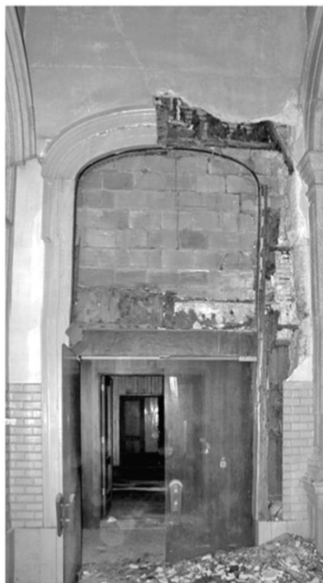
Imagem 29- Fotografia do patamar antes da obra de reabilitação de 2005-2009. Aqui pode-se observar o feixe de madeira que foi reconstruído e a pedra de mármore e granito. © Inês D'ourey, 2005.
