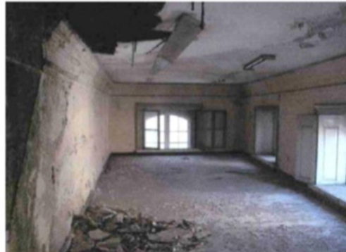
Imagem 33- Sala antes da obra de reabilitação com a laje de betão. Memória descritiva, 2005.
