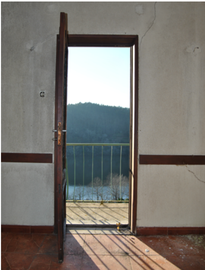
Fig. 57 | Interior do piso 2 e a paisagem do Rio Douro | Pré-existência em Zebreiros
