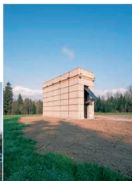
Figura 15 (a-b) Cham, Switzerland, Boltshauser Architekten, Prestressed Earth Furnace Tower, Ziegelei-Museum Cham, 2021 (foto di Kuster Frey) La torre della fornace è il primo edificio in terra precompressa al mondo: un esperimento costruttivo per l'architettura sostenibile. I cavi di tensionamento sono a vista.
