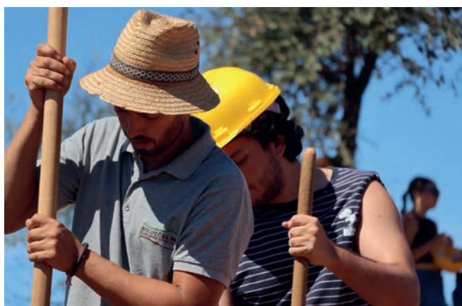
Figura 33 e 34 Trabalho de compactação da terra. São Teotónio, 12 de Setembro de 2024. 37.419525° N, 8.698884° W.
