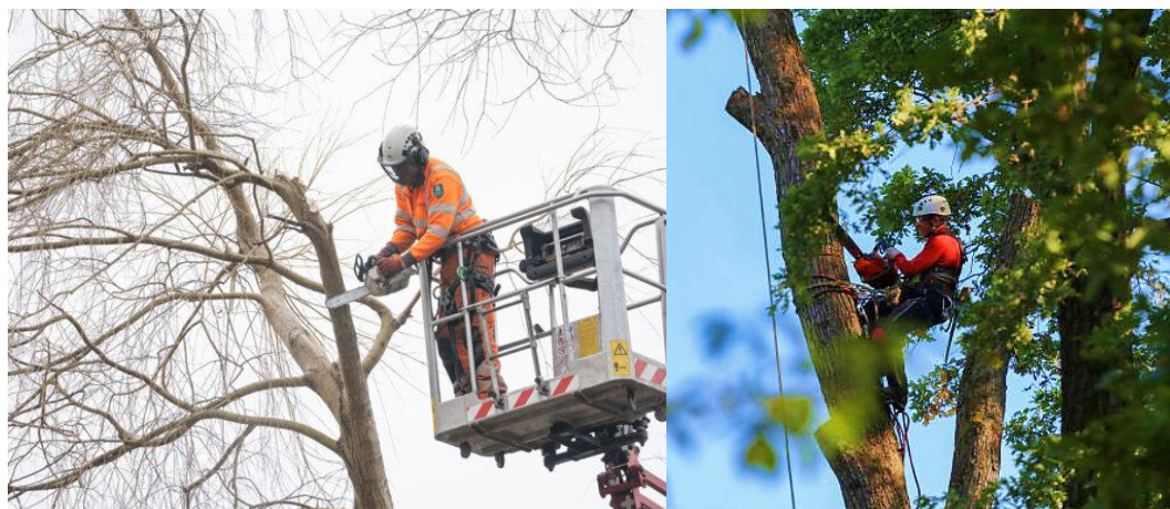
Figura 2 - Métodos de acesso em arboricultura: plataforma elevatória (esq.) e por corda (dir.).
