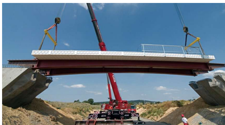
Fig. 2.7 - Instalação de tabuleiro modular misto
