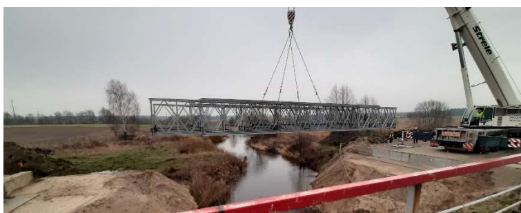
Fig. 2.10 - Montagem de uma Ponte Acrow (ViaCon)
