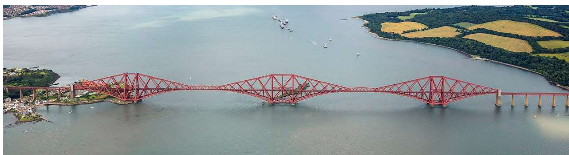
Fig. 2.4 - Forth Bridge (Escócia)
