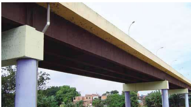
Fig. 2.5 - Tabuleiro em vigas metálicas longitudinais padronizadas
