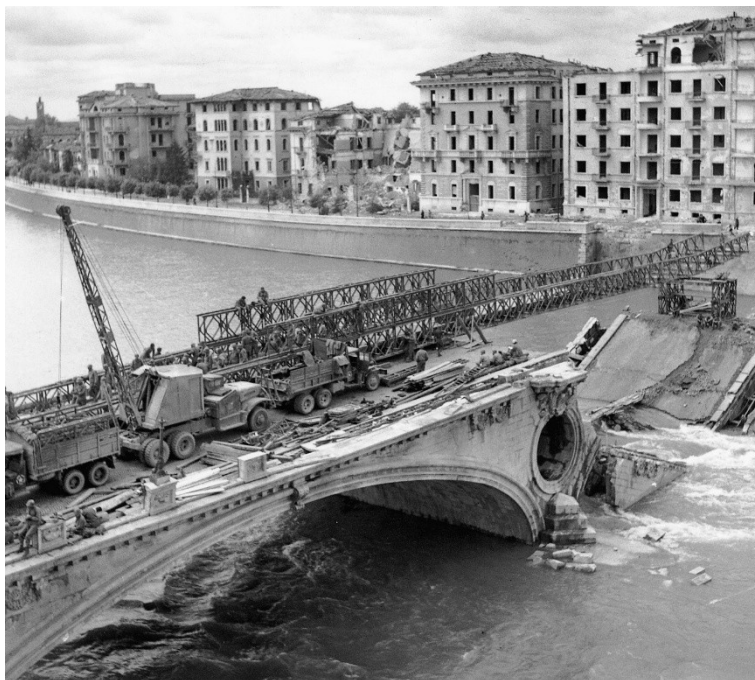
Fig. 2.9 - Montagem de uma Ponte Bailey em situação de guerra
