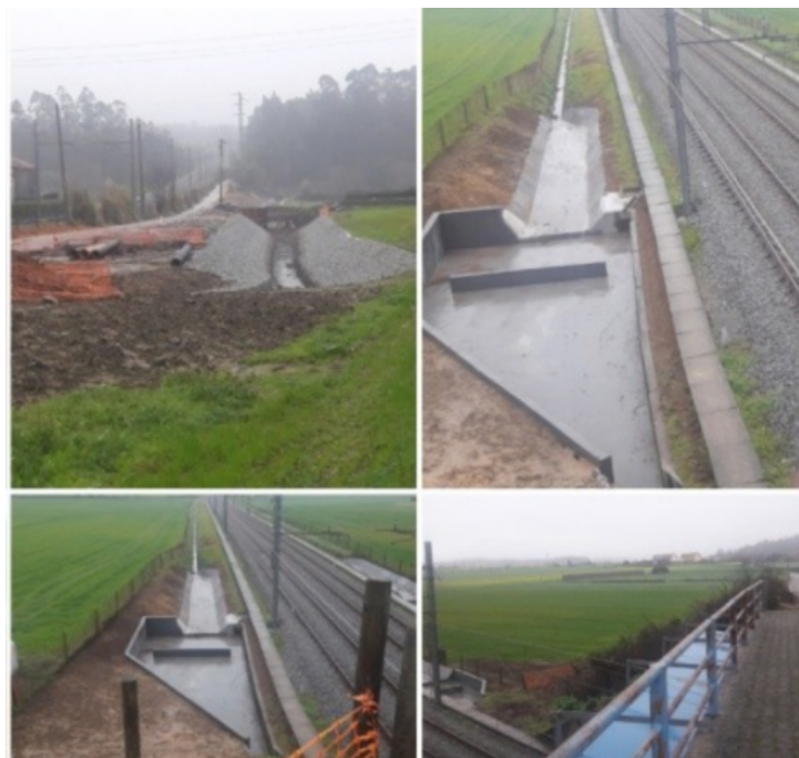
Figura 15 - Requalificação da rede de drenagem: estação Modivas Sul (imagens facultadas pela MP, 2025)
