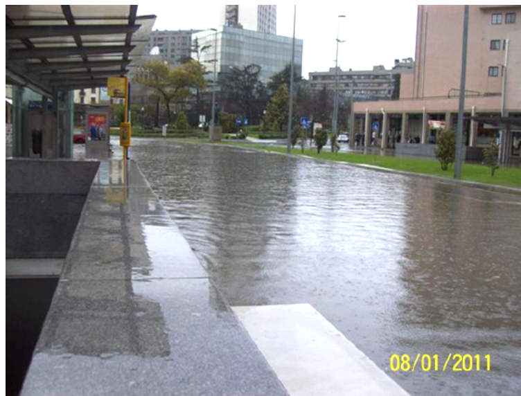
Figura 11 - Exterior da estação Campo 24 de agosto inundado, que resultou na inundação da estação (fonte interna)
