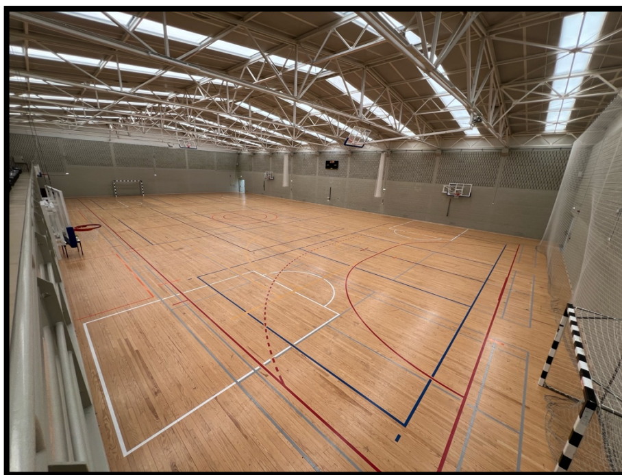
Figura 1 - Pavilhão Desportivo da Escola Secundária Abel Salazar
