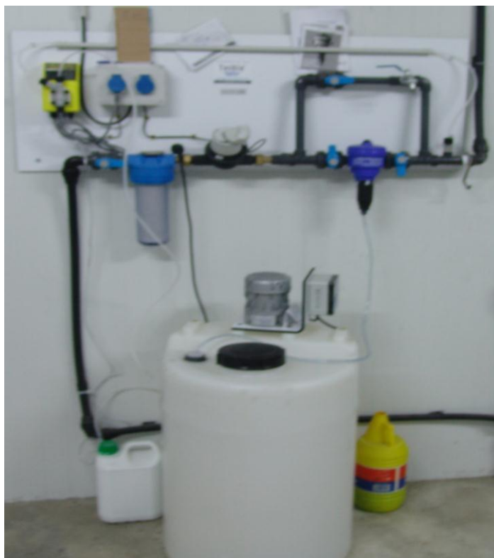
Fotografia 13: Depósito para a preparação de medicação, a administrar pela água de consumo; associado a um dosificador de Peroxido de Hidrogénio.
