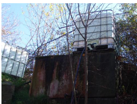
Fotografia 11: Reservatórios de água exteriores.
