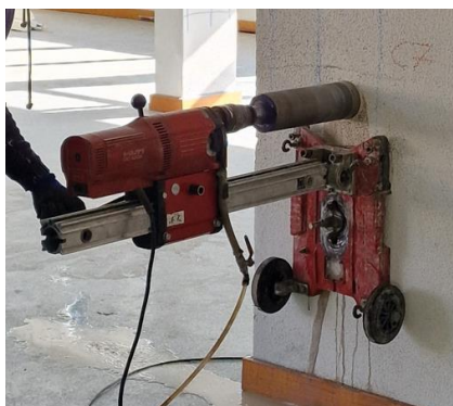
Figura 8 – Extração e modo de rotura do carote do betão. (ICS, 2025)
