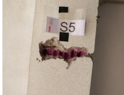
Figura 9 - Aplicação de fenolftaleína numa janela de sondagens. (ICS, 2025)
