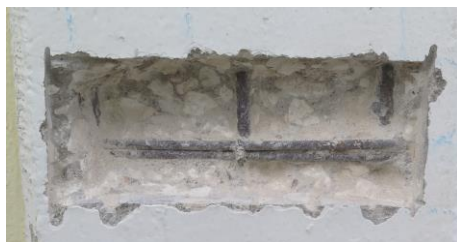
Figura 6 - Janela de sondagem num pilar. (ICS, 2025)
