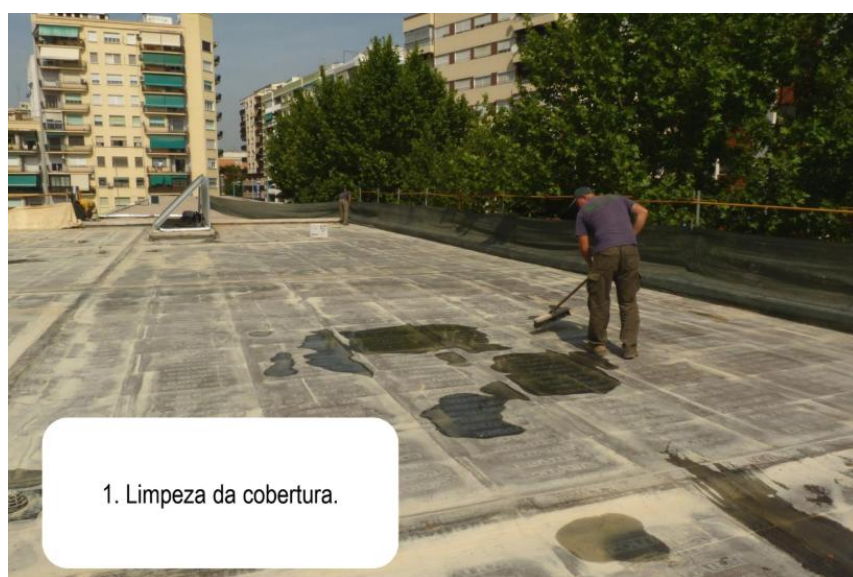
Figura 30 - Limpeza da Cobertura
