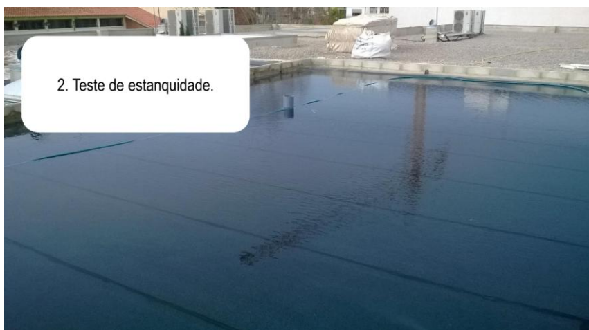
Figura 31 - Teste de estanquidade
