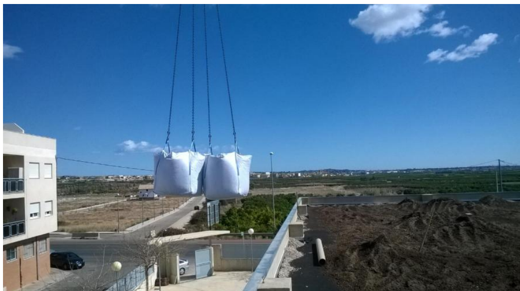
Figura 38 - Alocação do substrato por meio de BigBags
