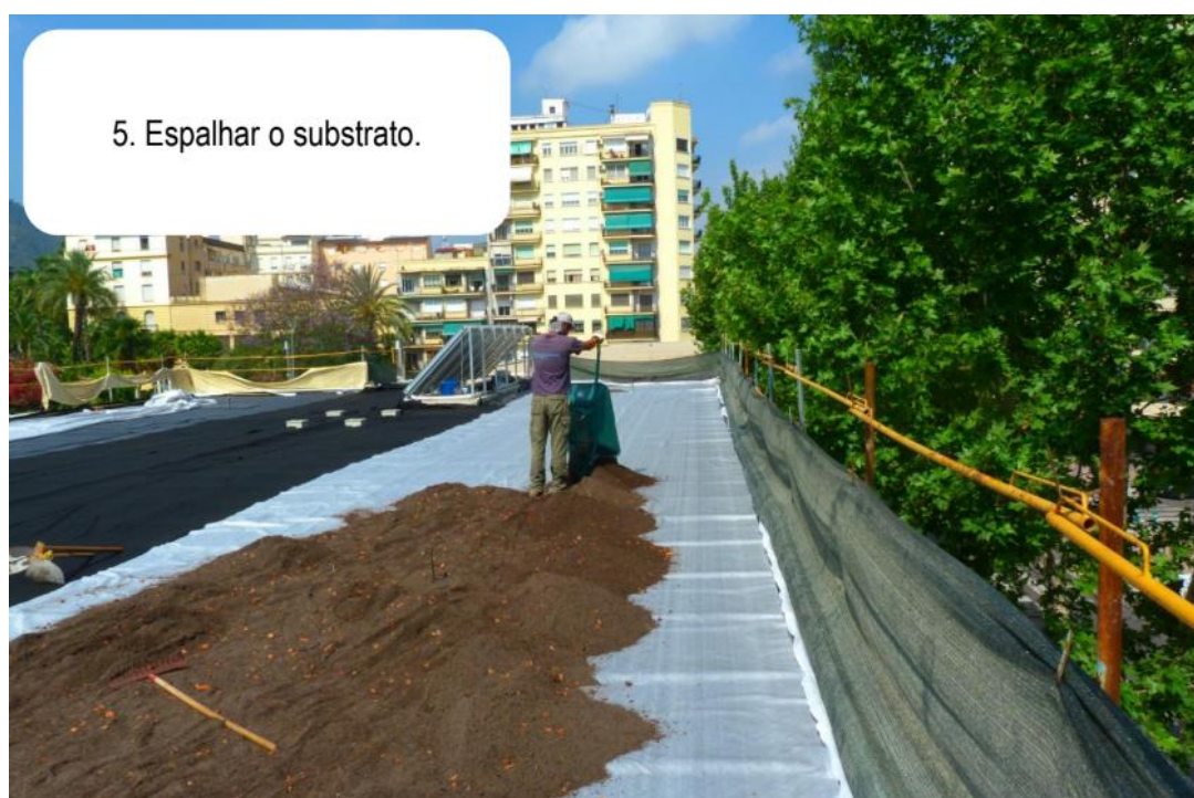
Figura 37 - Colocação do substrato
