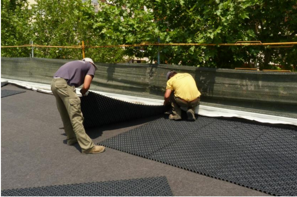
Figura 33 - Aplicação elemento de drenagem
