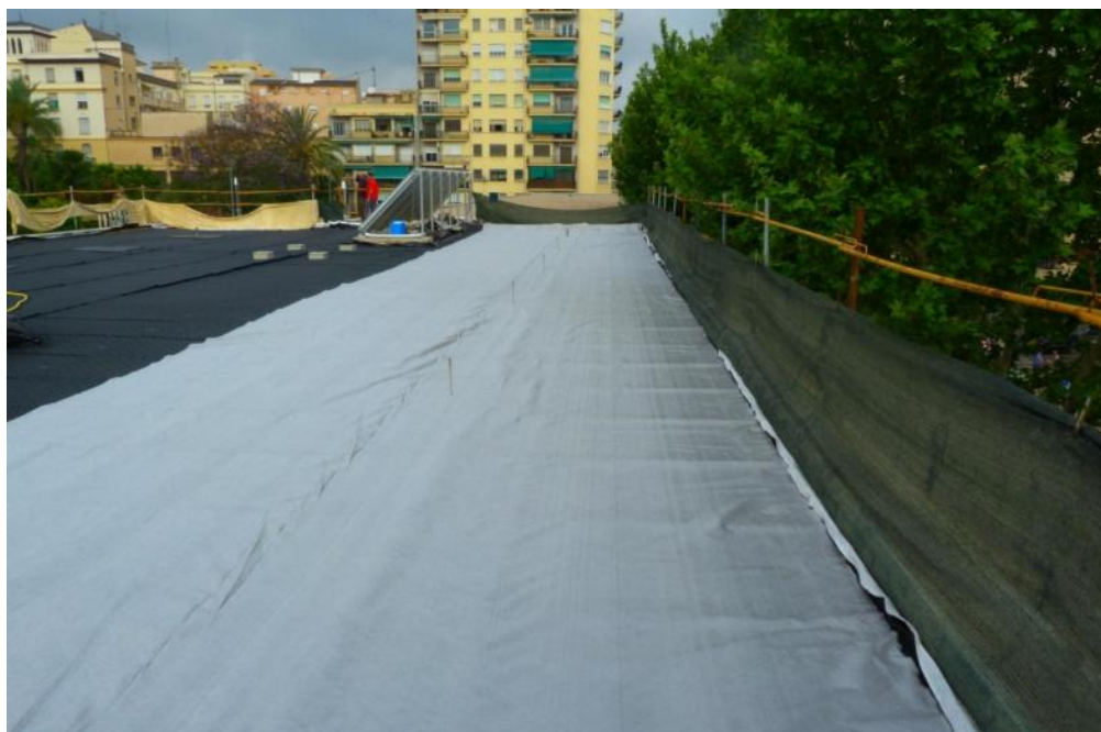
Figura 35 - Aplicação do filtro em forma de manta
