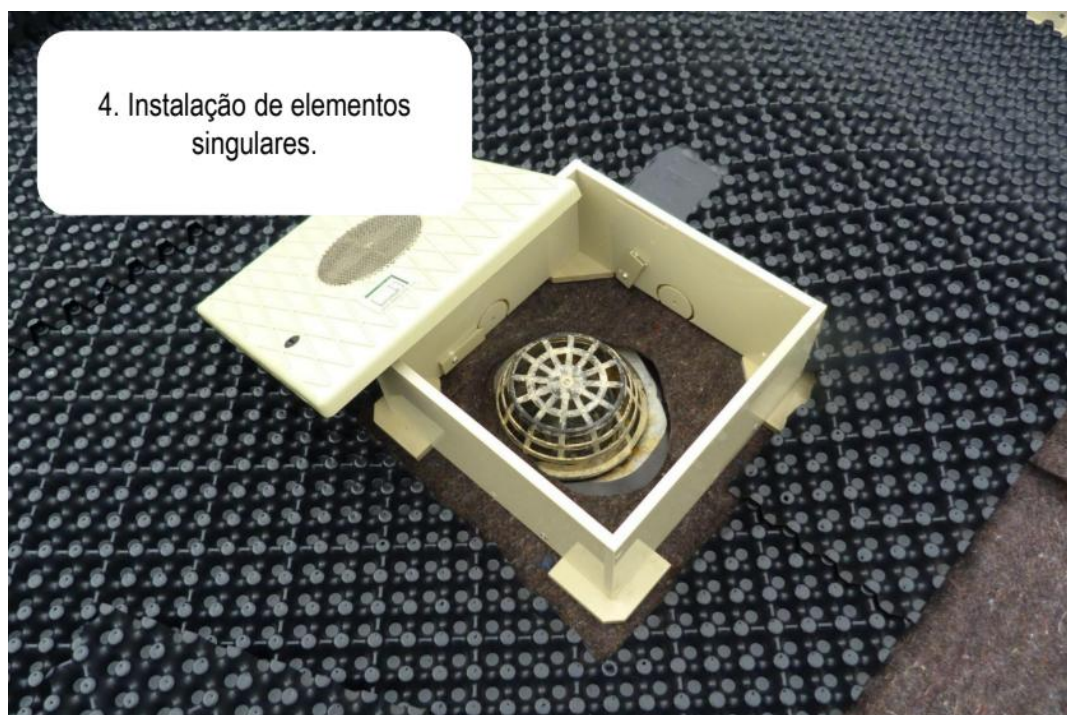
Figura 36 - Instalação de drenos
