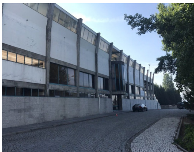
Fig. 1: Imagem da fachada Nordeste das Bancadas do estádio municipal de Mangualde. 40°36'08.1"N ; 7°45'07.1"W
