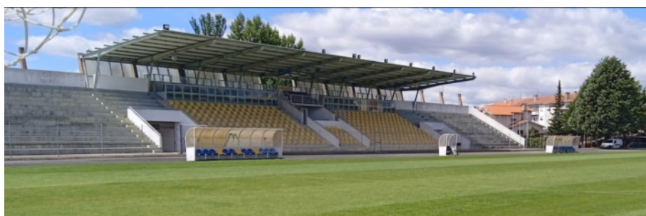
Fig. 3: Imagem referencial, estrutura da cobertura do estádio de Mangualde (Google Street Map)
