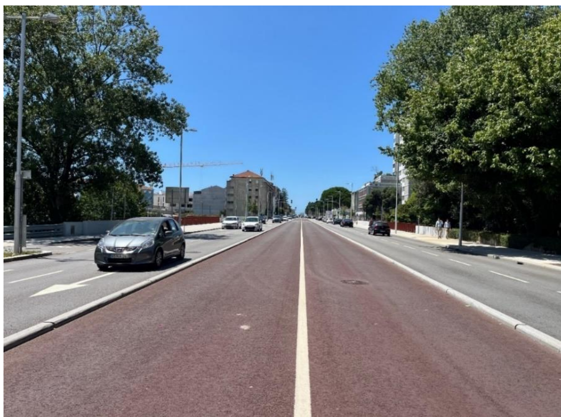
Figura 2 - Corredor BRT na Avenida da Boavista, Porto
