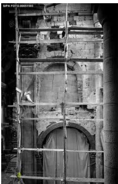
Aspetto do arco entaipado no transepto sul da Sé do Porto, antes, durante e após a intervenção da D.G.E.M.N. (s.d., Património Cultural, I.P.©, s.a. 113 ).
