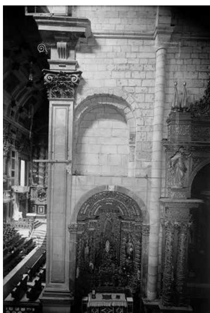
Aspetto do arco entaipado no transepto sul da Sé do Porto, antes, durante e após a intervenção da D.G.E.M.N. (s.d., Património Cultural, I.P.©, s.a. 113 ).
