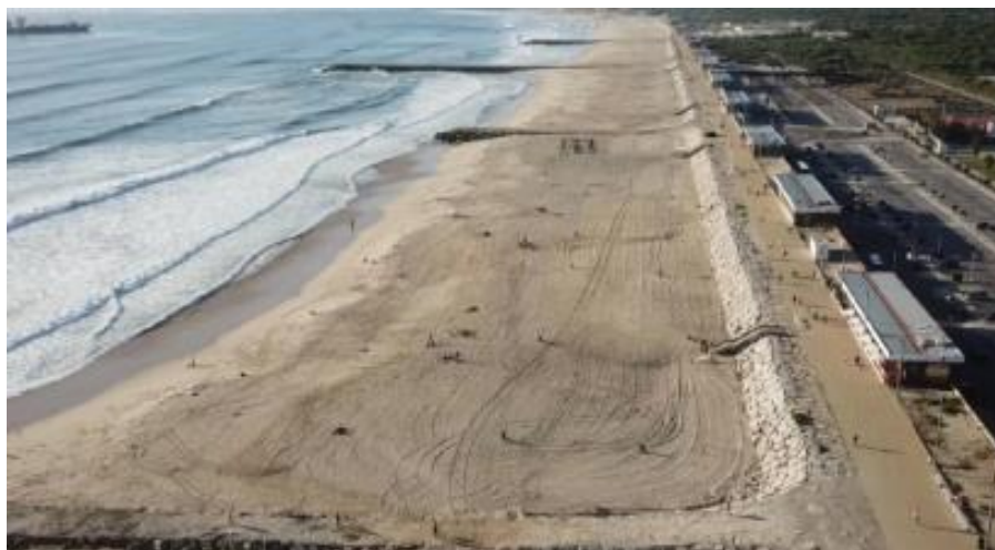
Figura 4 - Estruturas de Proteção na Praia de S. João da Caparica (Álvares, 2021).
