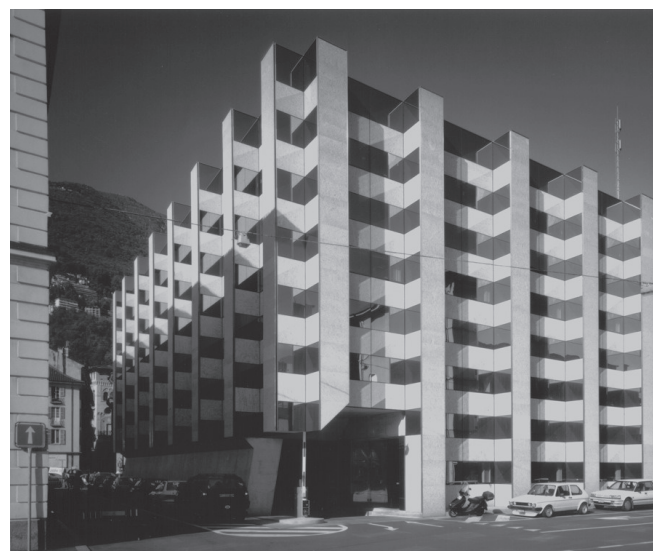
Fotografia do projeto Edifício postale , 1992-1995 de Livio Vacchini Locarno, Suíça.
