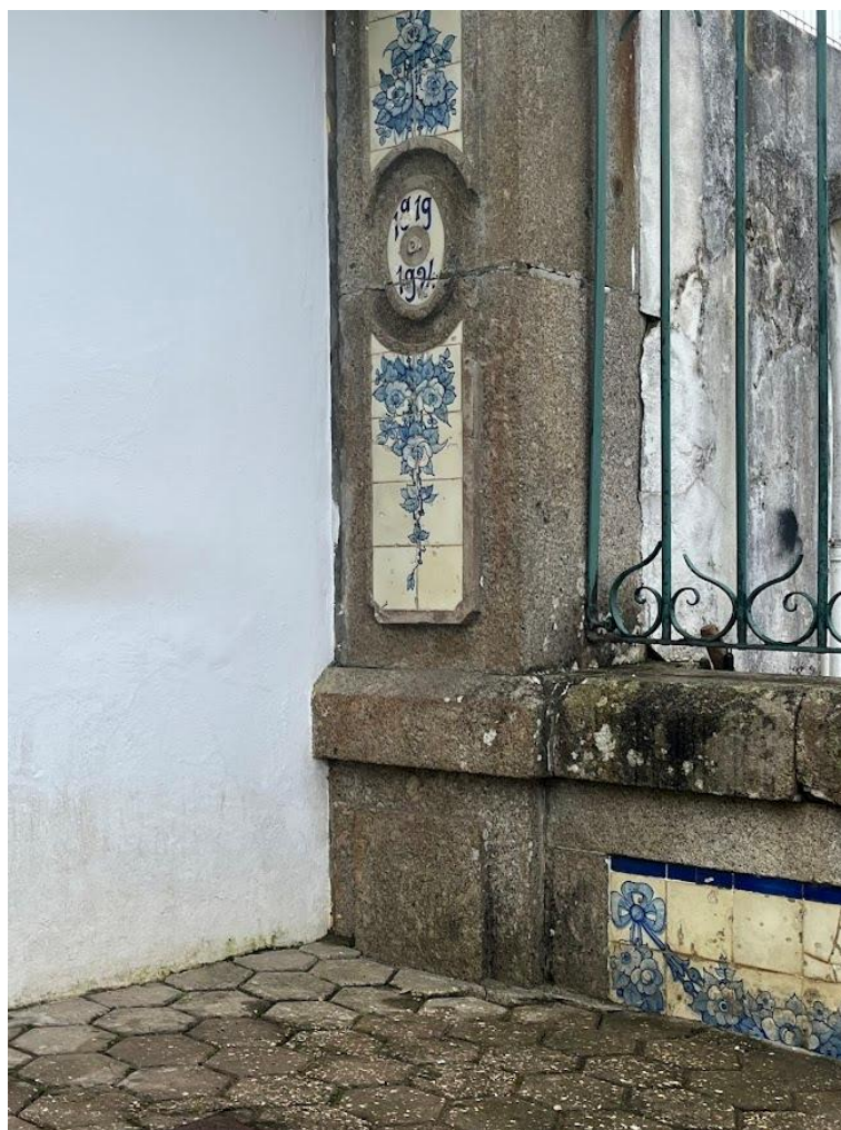
Figura 33 - Pilastra no ângulo este do cemitério de Crestuma.
