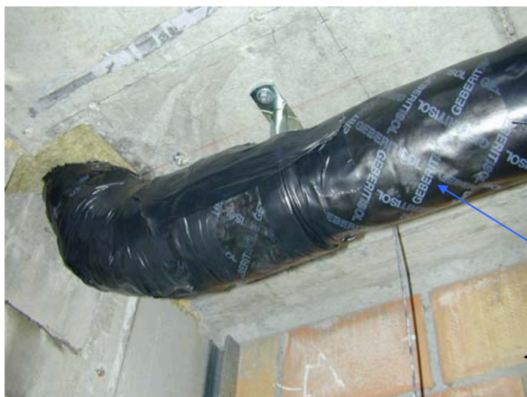
Figura 18: Tubo revestido com uma manga de desacoplamento, [12]
