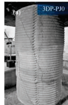
Concrete column formwork [28]
