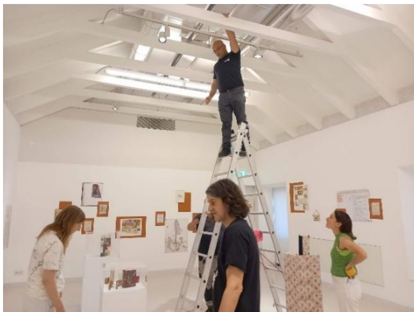
Fig. 39. Resolvendo a questão da iluminação na Sala C.
