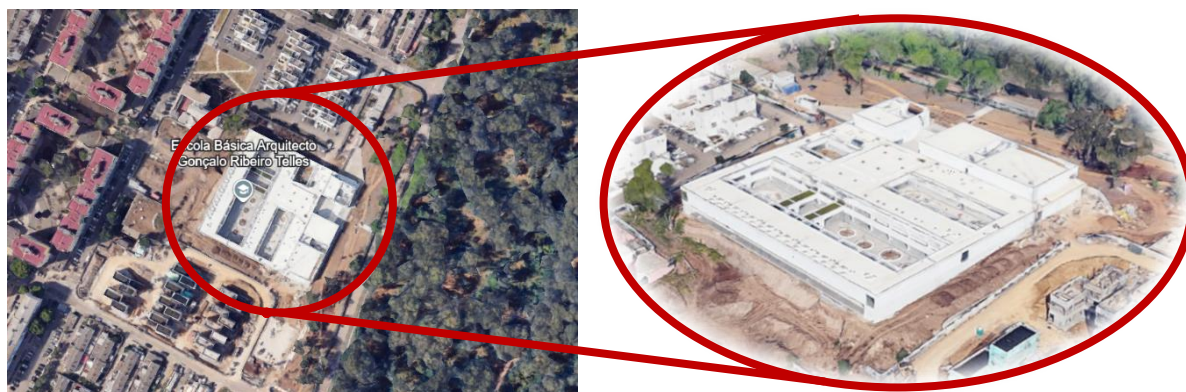
Figura 8- Vista aérea da Escola Básica Arquitecto Gonçalo Ribeiro Telles, via Google Maps e Google Earth
