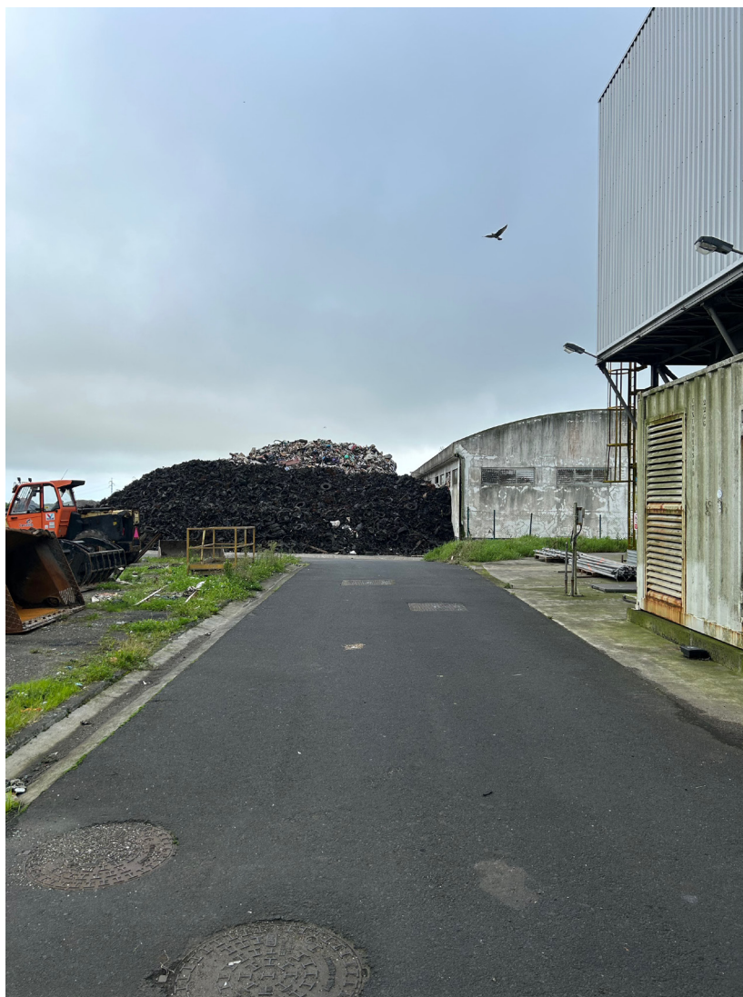
Fig. 10.8 - Instalações da TERAMB, ilha Terceira, outubro de 2023.
