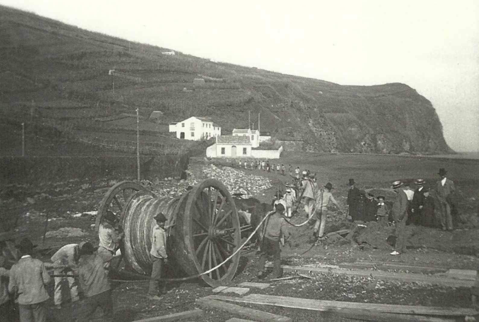
Fig. 9.5 - Instalação do primeiro cabo submarino na praia da Conceição, ilha do Faial, 1893.
