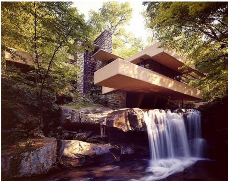
13. Vista da Casa da Cascata.
