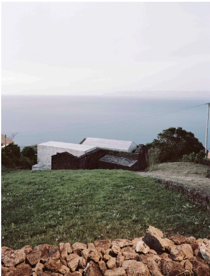
88. Vista tardoz da Casa E/C.
