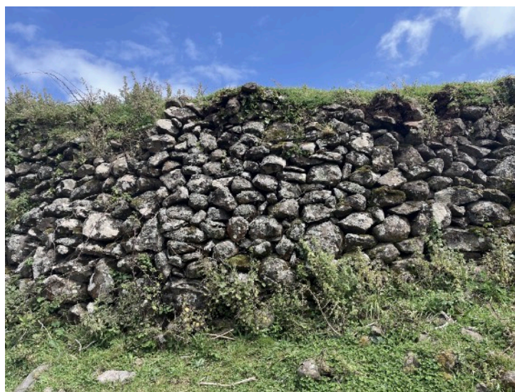
116. Muro de contenção no terreno, em pedra local com junta seca.
