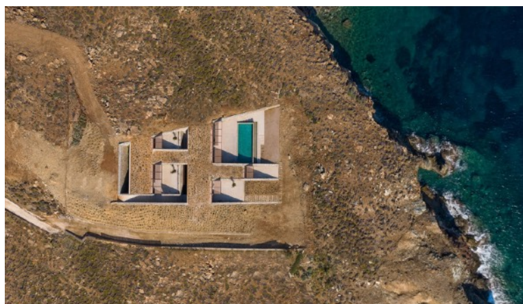
41. Vista aérea do edifício.
