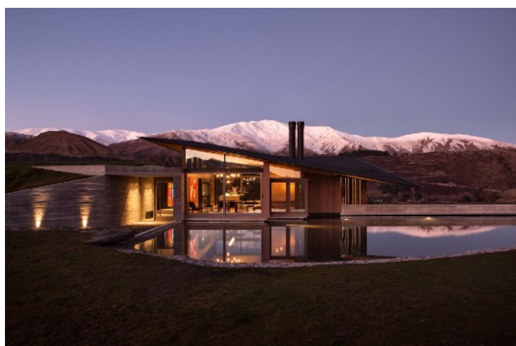
80. Fachada lateral do edifício destinado aos hóspedes.
