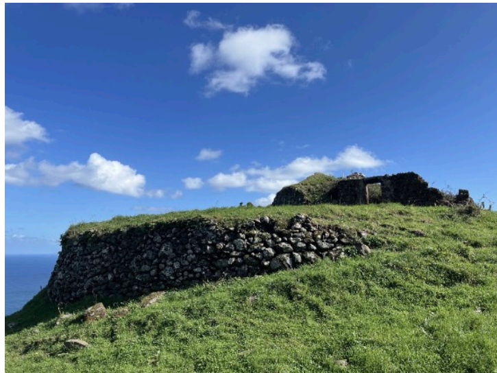
101. Fotografia do terreno ao entrar, com pré-existência e muro de suporte.
