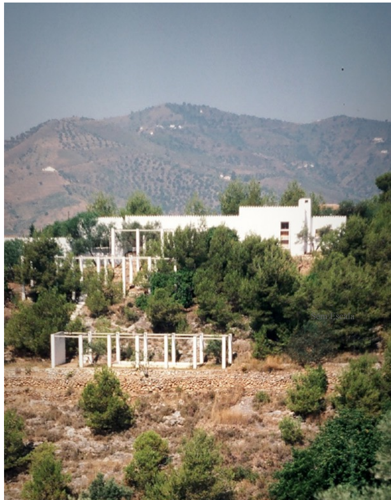
24. Vista da fachada sul.
