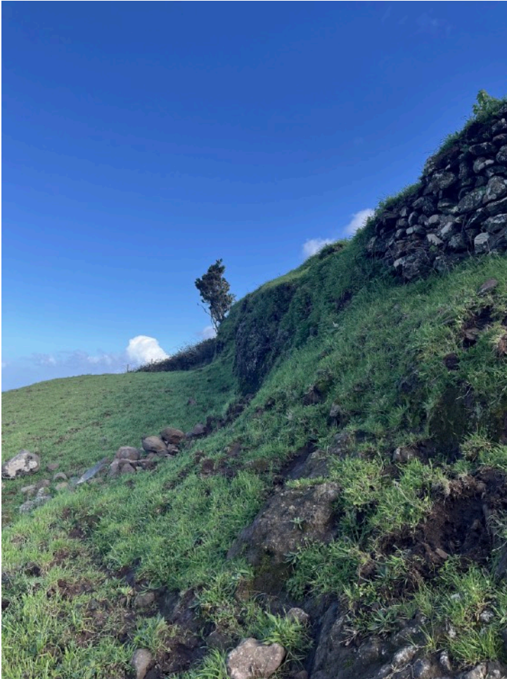
115. Rocha existente no terreno na continuidade do muro de suporte, foto tirada da cota 297, a olhar a este.
