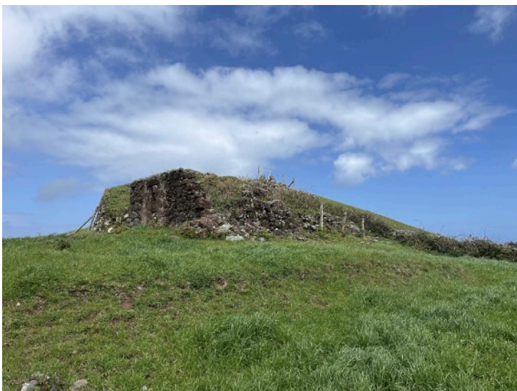
118. Ruína de palheiro existente no terreno.
