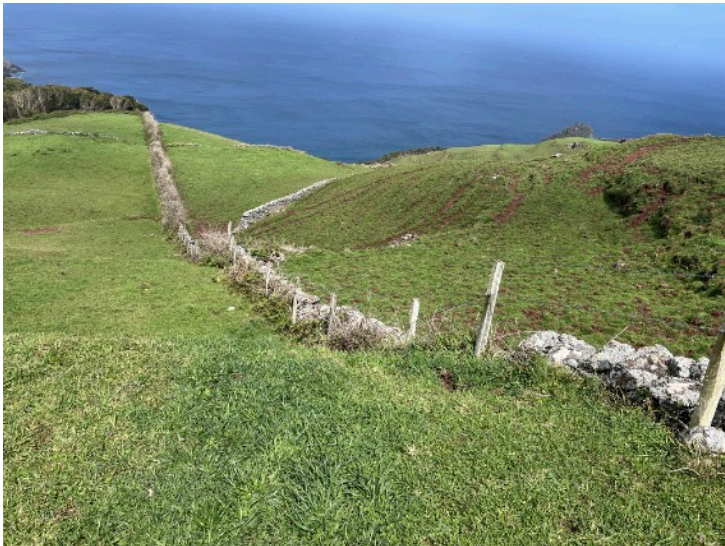
117. Muros de delimitação do terreno, em pedra local com junta seca.
