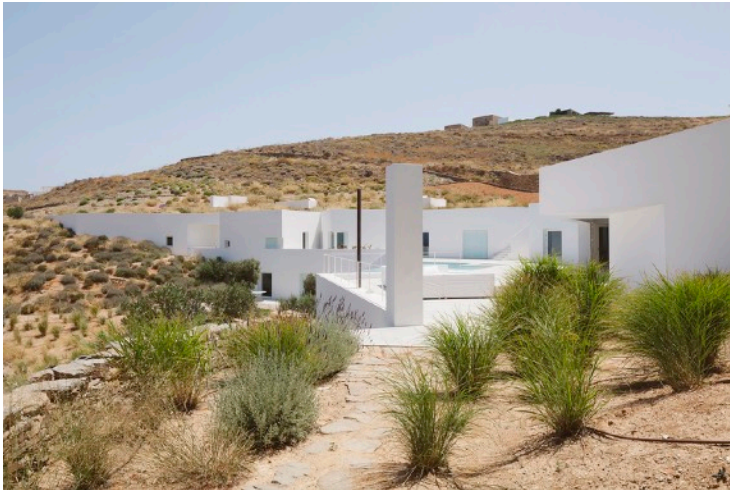
68. Vista lateral da casa Ktima.
