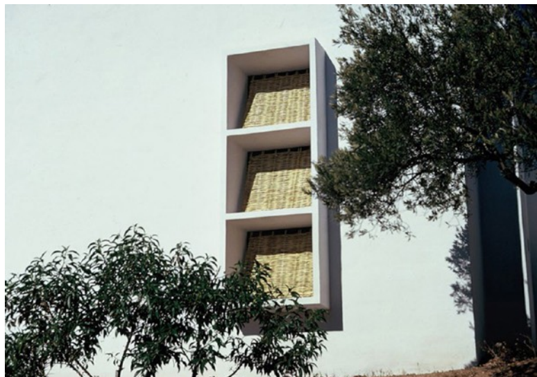
27. Detalhe da proteção solar nas janelas.
