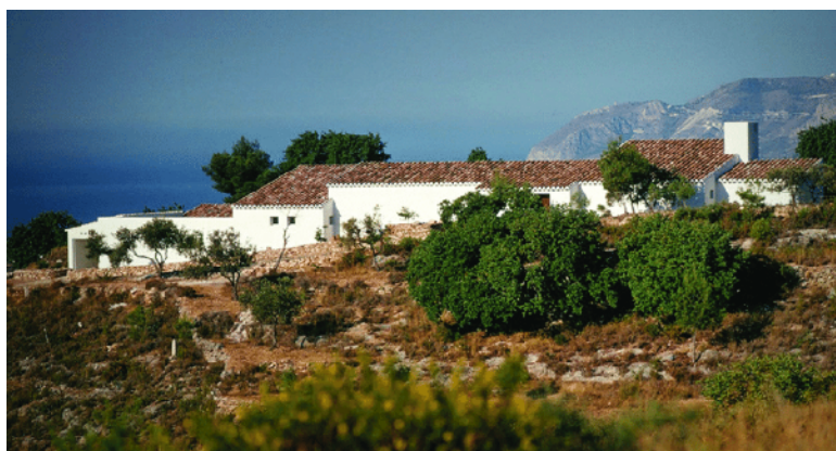
23. Vista da fachada norte.
