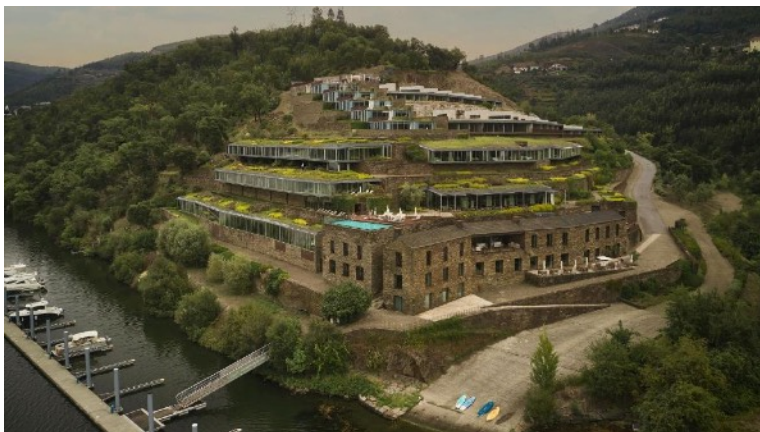
40. Vista aérea do edifício.
