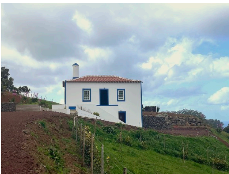
3. Casa típica mariense recentemente reconstruída com loja e balcão, localizada no lugar da Azenha, freguesia de Santa Bárbara, ilha de Santa Maria.
