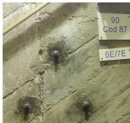
Figura 20 - Base de alongâmetro, retirado de (Rebelo 2020).
