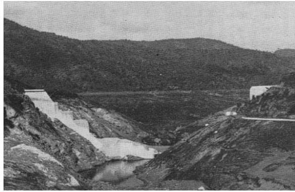
Figura 4 - Ruínas da barragem de Malpasset (Duffaut, P., 2013).
