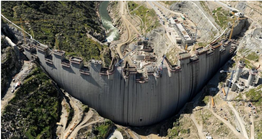
Figura 30 - Barragem do Baixo Sabor, em fase de construção, adaptado de (FCM, Consult. 12/06/2025).
