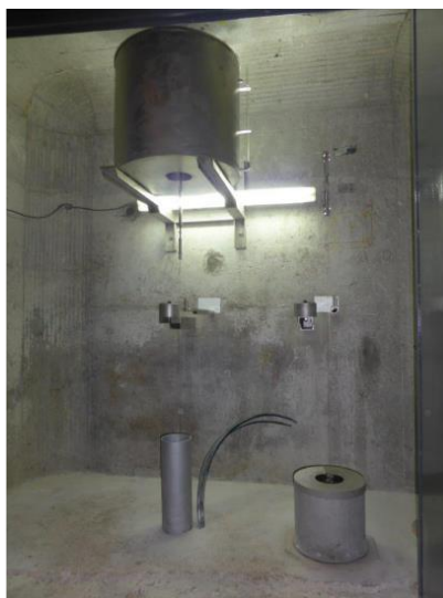
Figura 17 - Nicho de Fio de prumo (direito e invertido), retirado de (Barros, P.S., J., 2016)
