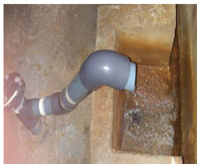
Figura 22 - Dreno de galeria drenante, retirado de (Moura, G.M.G., 2005)
