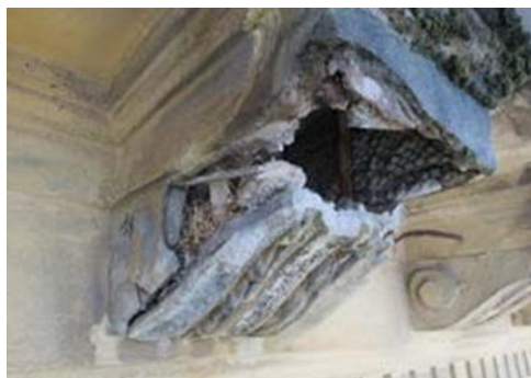
Figura 25 – Mísula fingida degradada [120].
