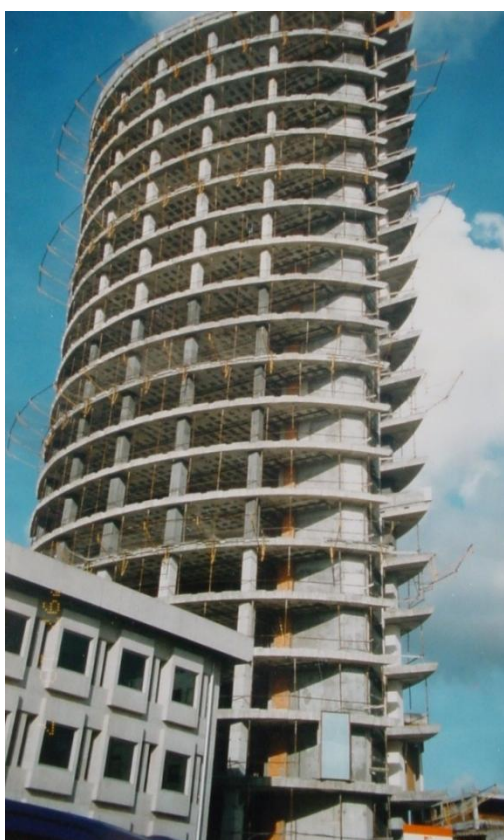
Figura 75 - Edifício em conceção
