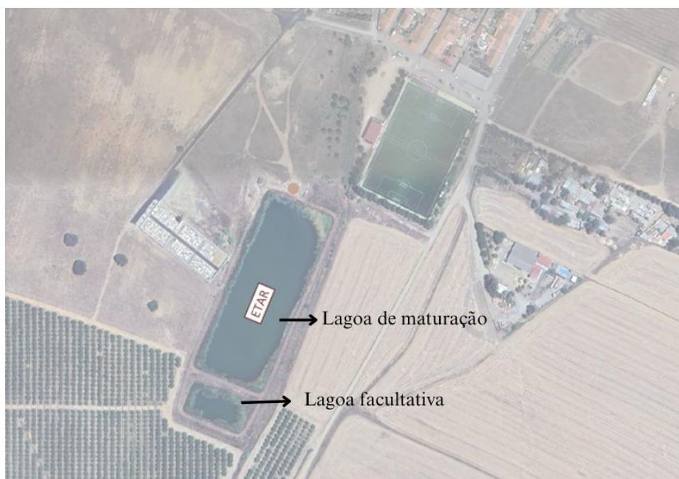
Figura 13 – ETAR Penedo Gordo (Fonte: Hidrofunção – Consultores de Engenharia, Lda.)
