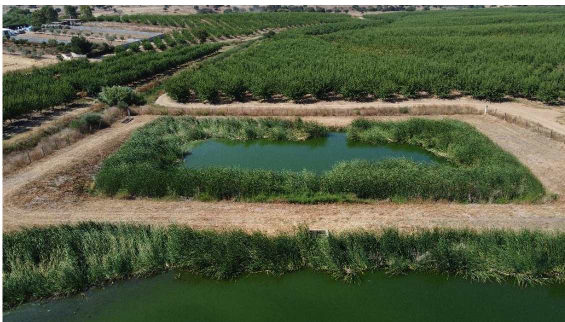
Figura 14 – Estado das lagoas de estabilização, ETAR Penedo Gordo (Fonte: Hidrofunção – Consultores de Engenharia, Lda.)
