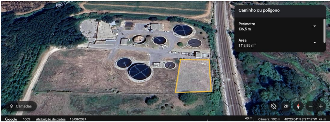
Figura 25 – Estimativa área de instalação painéis solares, ETAR da Mealhada (Google Earth ®)
