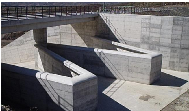
Figura 2 - Barragem de Santa Justa, soleira em labirinto trapezoidal (Minds, [s.d.])
