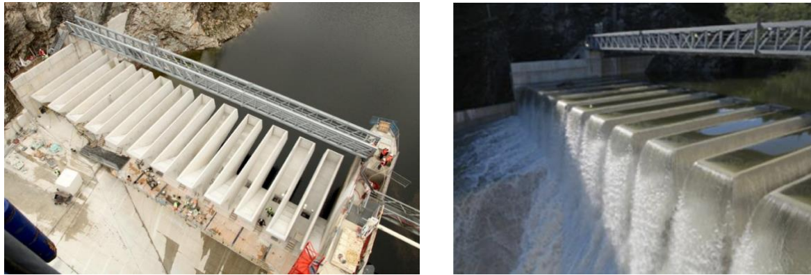
Figura 13 - Barragem de Malarce ( Data Sheet (PKW Malarce, EDF) , [s.d.]; Monograph Barrage de Malarce , [s.d.])
