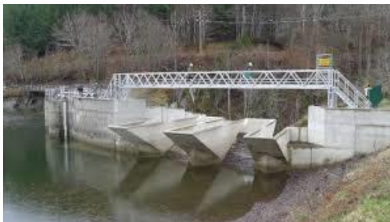
Figura 12 - Barragem de Goulours ( Monograph Barrage de Goulours , [s.d.])
